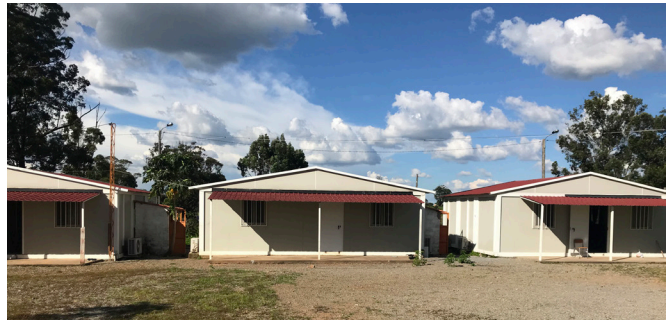
Alojamentos da Missão do Dondi próximo à aldeia de Catchiungo
