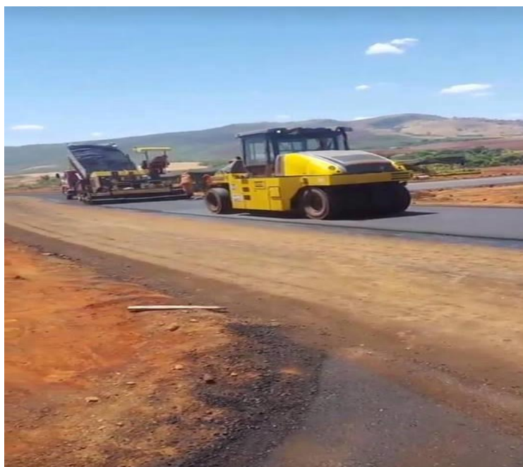
Figura 4.5 - Caminhão caçamba descarregando o material CBUQ, juntamente com o rolo compactador liso. (autor próprio)
