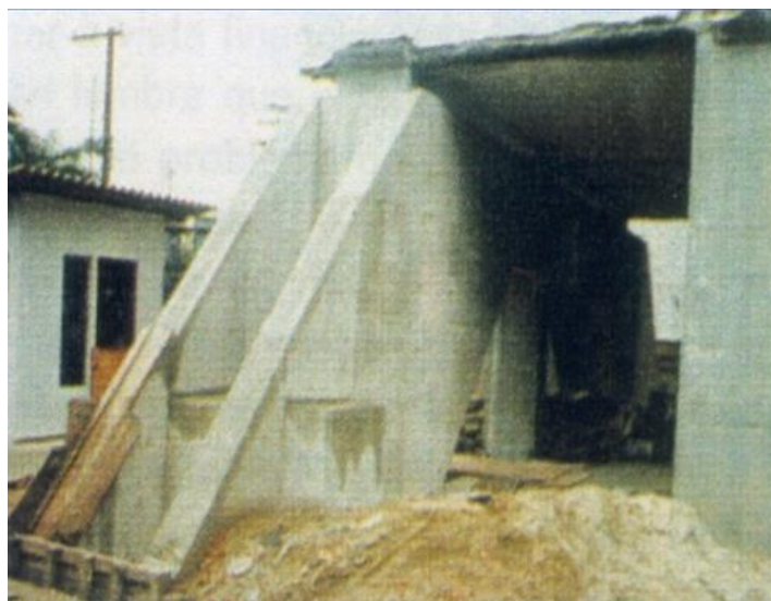
Figura 4. 8 - Vigas de transição Virandeel.
