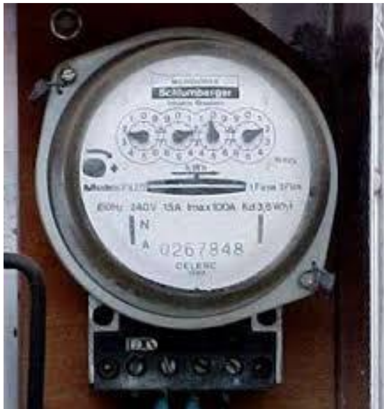
Figura 4.2 - Medidor Eletromecânico com Visualizador Tipo Ponteiro. (Fonte: http://www.salfatis.com.br )
