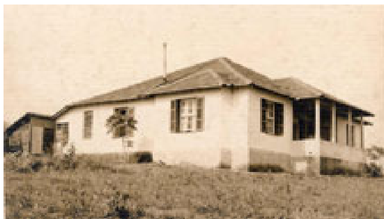
FIGURA nº 2: Primeiras instalações da UniEVANGÉLICA Fonte: UNIEVANGÉLICA (2008 b).
