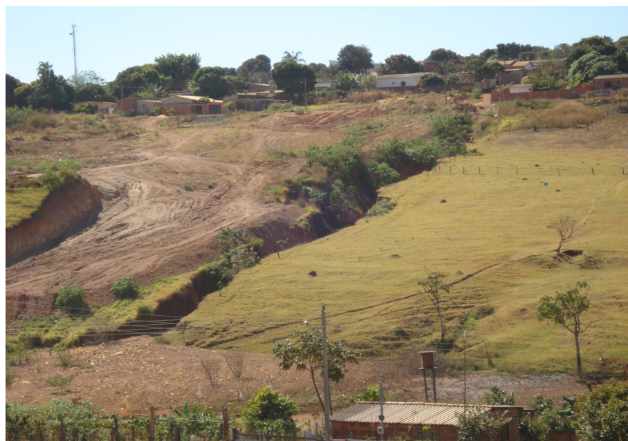
Figura 2.10: Vista de uma das erosões no Bairro Residencial Morumbi/Jibrán do município de Anápolis (GO) nas proximidades do ponto de coleta n° 3.
