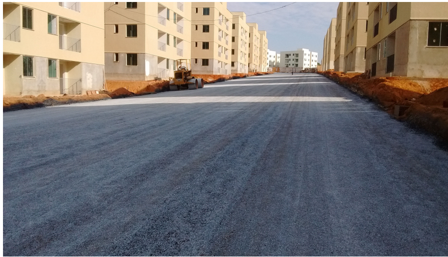
Figura 20 – Compactação da brita 0 com o rolo liso
