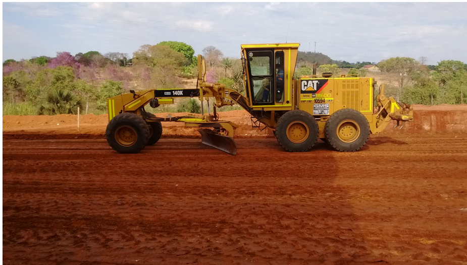
Figura 13 – Retirada dos excessos de cascalho e nivelamento da via
