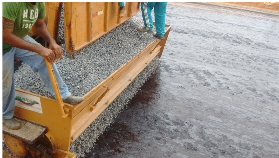
Figura 19 – Distribuição da brita 1 sobre o RR-2C
