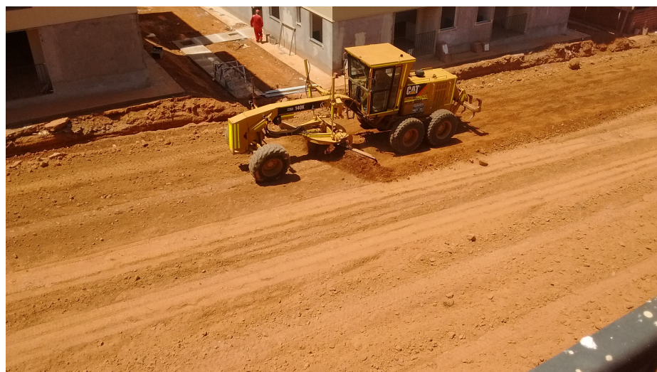
Figura 09 – Tombamento do material na via
