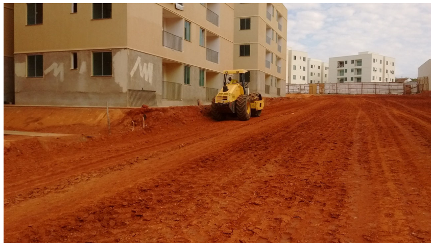
Figura 04 – Compactação do terreno após sua regularização
