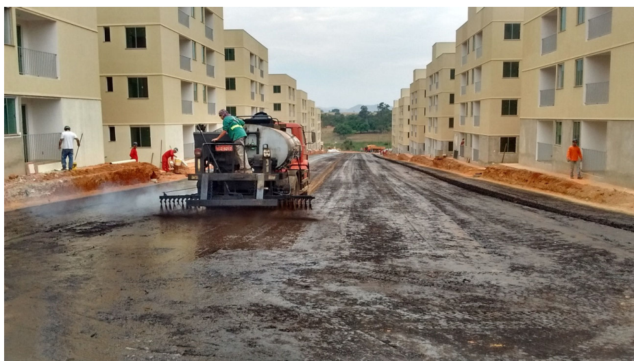
Figura 17 – Aplicação do RR-2C na via
