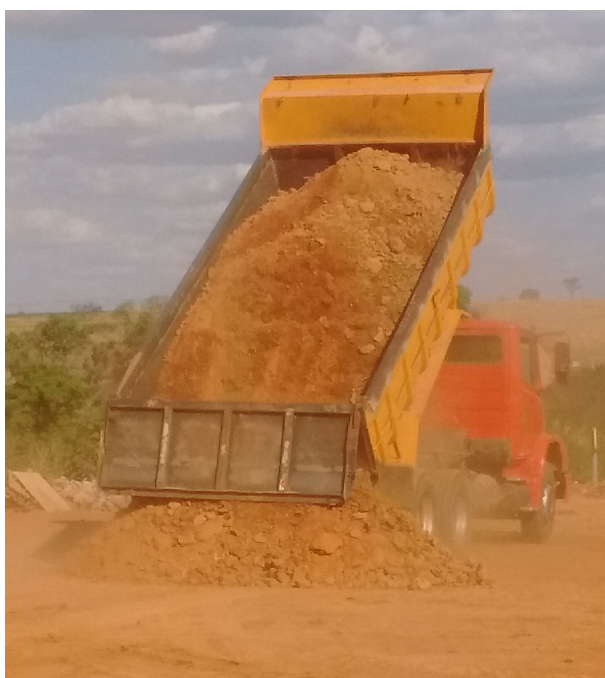
Figura 05 – Entrega de cascalho no canteiro de obras
