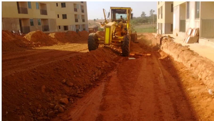
Figura 07 – Distribuição do material sobre a via a ser pavimentada
