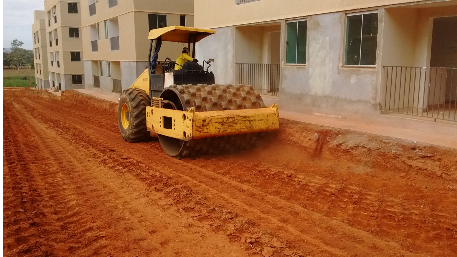
Figura 10 – Compactação da via após umidificação
