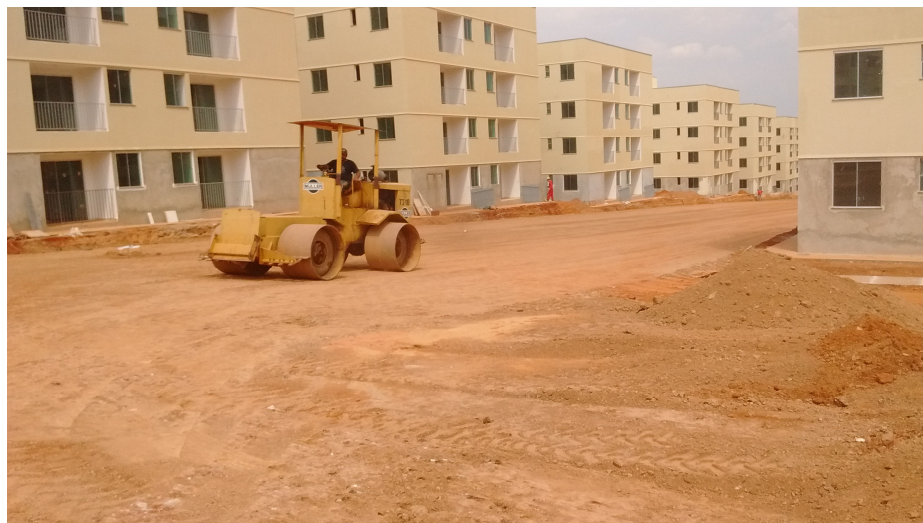
Figura 14 – Acabamento da via com o rolo liso
