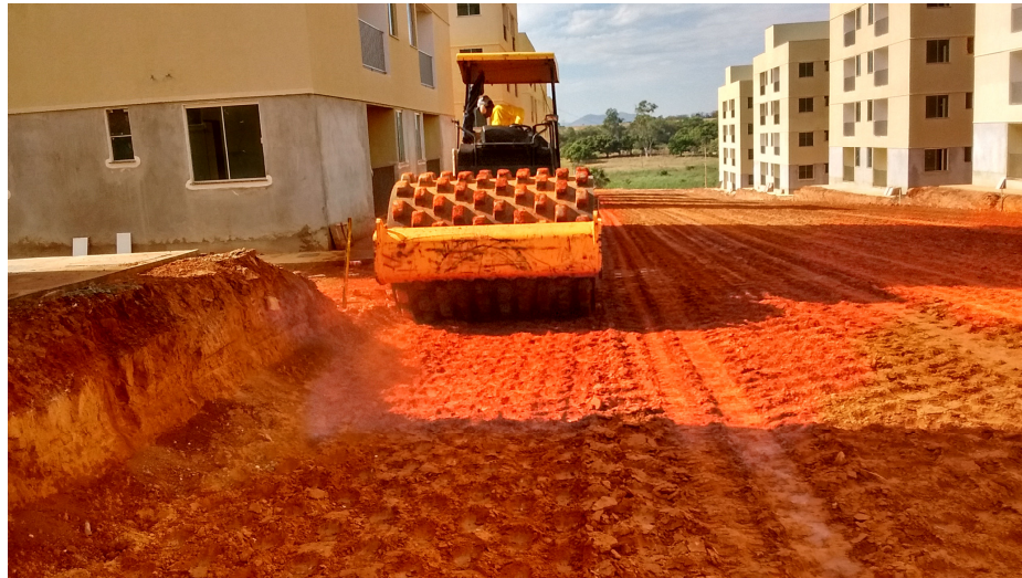
Figura 12 – Nova compactação da via
