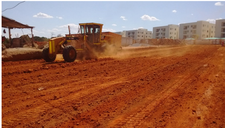
Figura 03 – Regularização do subleito da via a ser pavimentada
