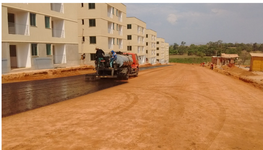
Figura 15 – Etapa de imprimação da via com CM-30
