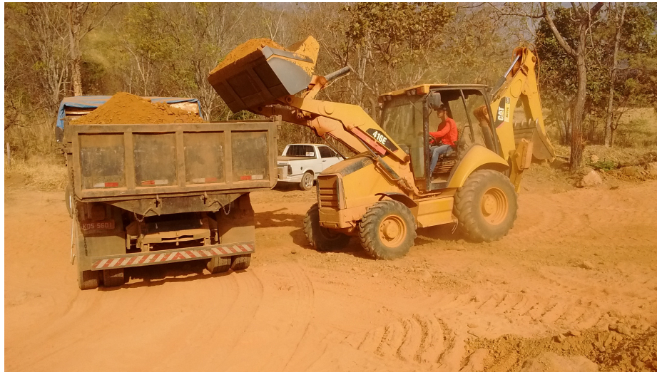
Figura 06 – Devolução do cascalho em razão de granulometria inadequada
