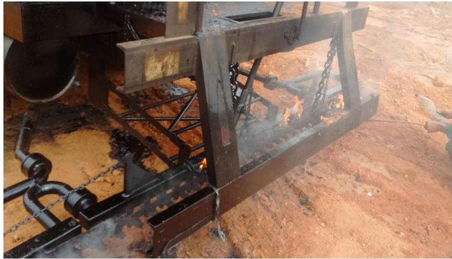
Figura 18 – Aquecimento do espargidor de CM-30 e RR-2C
