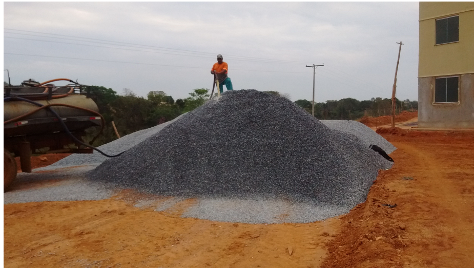
Figura 16 – Lavagem dos agregados (britas 0 e 1).
