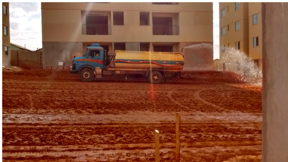
Figura 11 – Umidificação da via após a compactação
