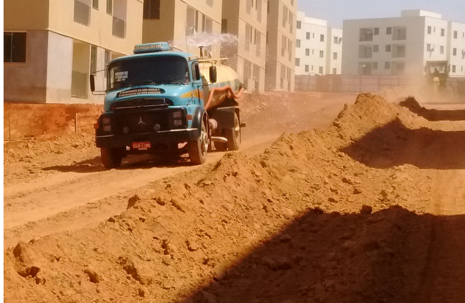
Figura 08 – Umidificação do material distribuído na via
