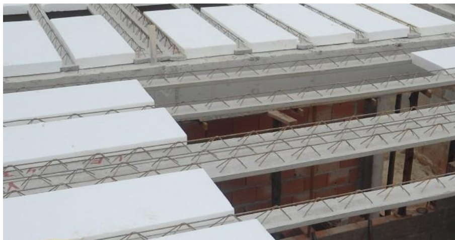
Figura 10 -Vigotas e blocos de EPS. Fonte: Trelicon (2016)
