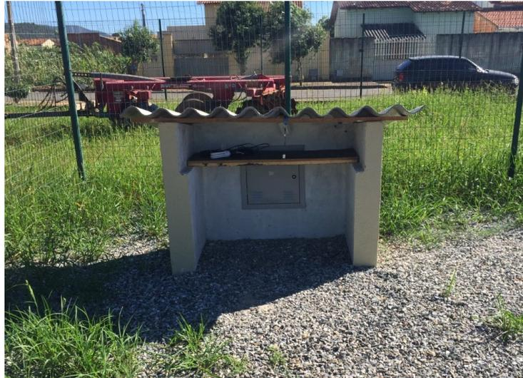
**Figura 8:** Célula de apoio para a caixa do sistema de aquisição de dados.
