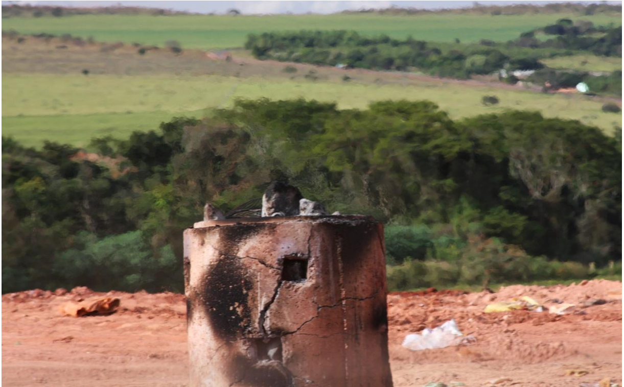
Figura 23: Queima de gases em tubo de concreto do Aterro Sanitário de Anápolis Estado de Goiás. Fonte: Elaborado pela autora (2011)
