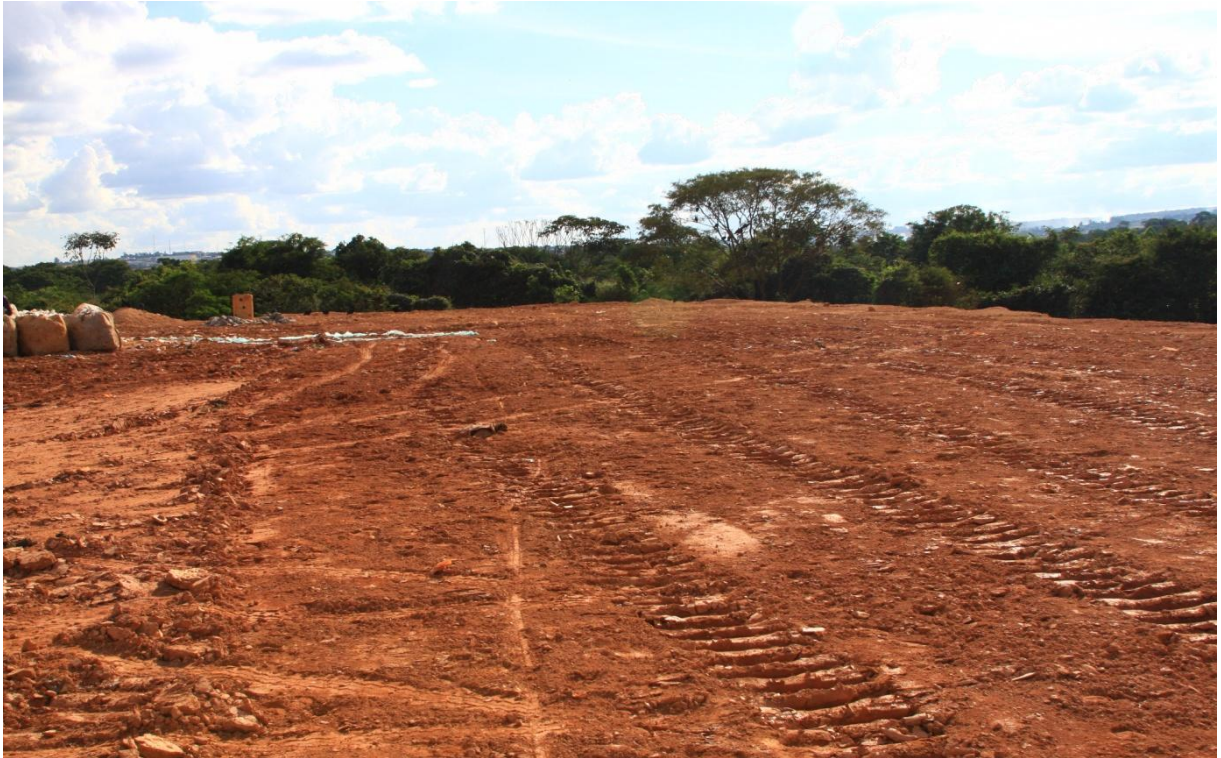
Figura 22: Área da trincheira compactada e coberta com terra do Aterro Sanitário de Anápolis Estado de Goiás. Fonte: Elaborado pela autora (2011)
