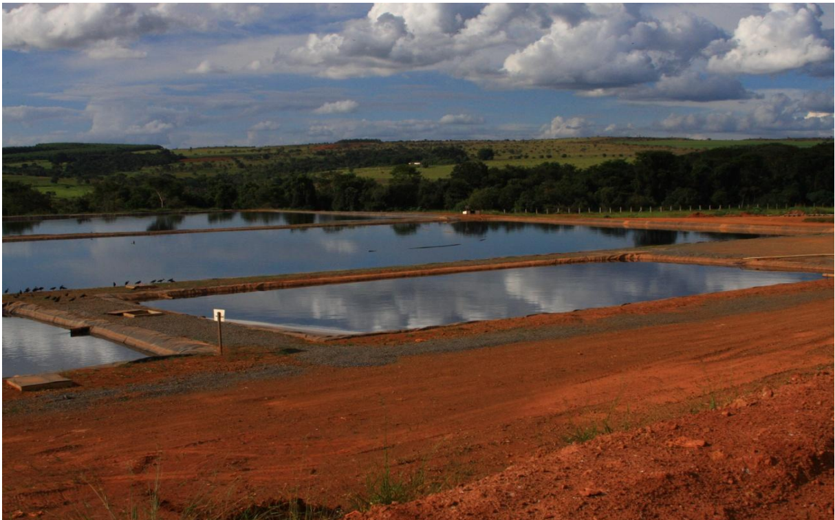
Figura 27: Lagoas de estabilização do chorume do Aterro Sanitário de Anápolis Estado de Goiás.
