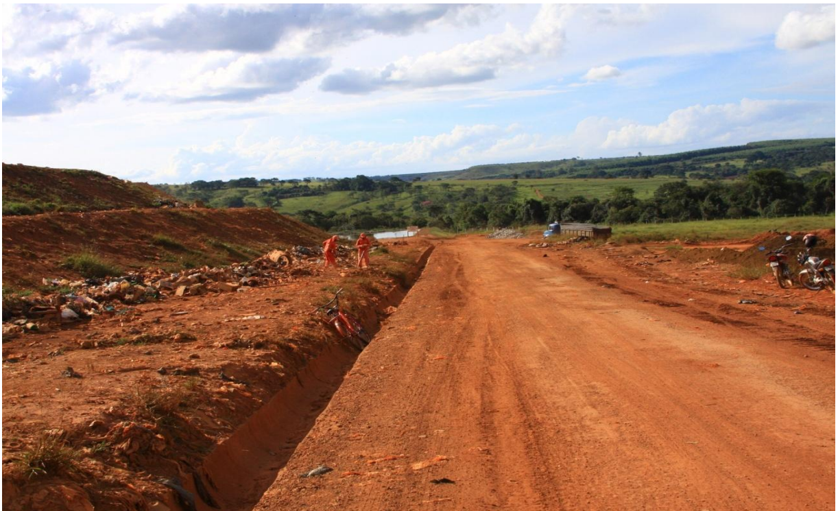
Figura 21: Trincheira verticalizada a esquerda, via de acesso interno e canaletas pluviais do Aterro Sanitário de Anápolis Estado de Goiás. Fonte: Elaborado pela autora (2011).
