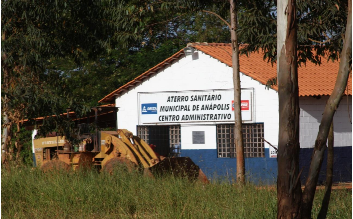
Figura 14: Sede Administrativa do Aterro Sanitário de Anápolis Estado de Goiás.
