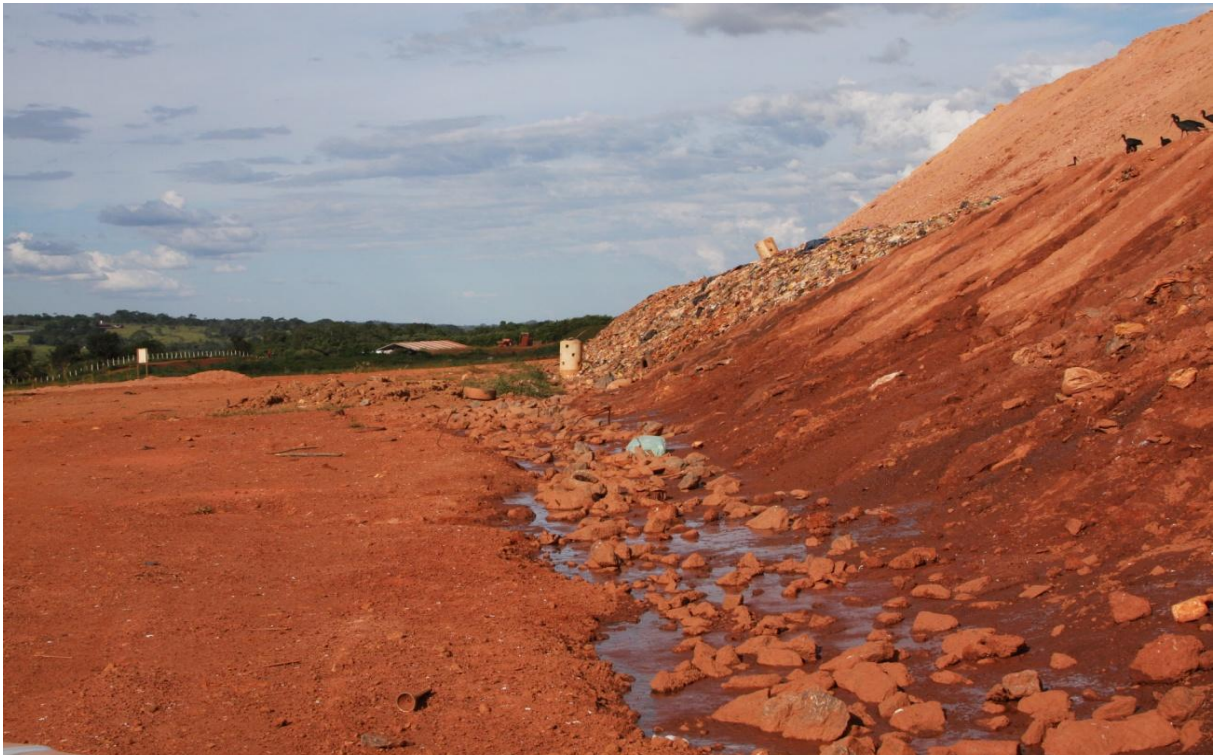
Figura 28: Escoamento superficial de chorume do Aterro Sanitário de Anápolis Estado de Goiás Fonte: Elaborado pela autora(2011).
