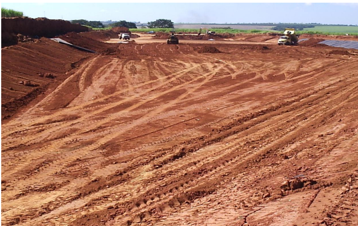
Figura 32: Aterro Sanitário de Franca, SP Fonte: Prefeitura Municipal de Franca - SP
