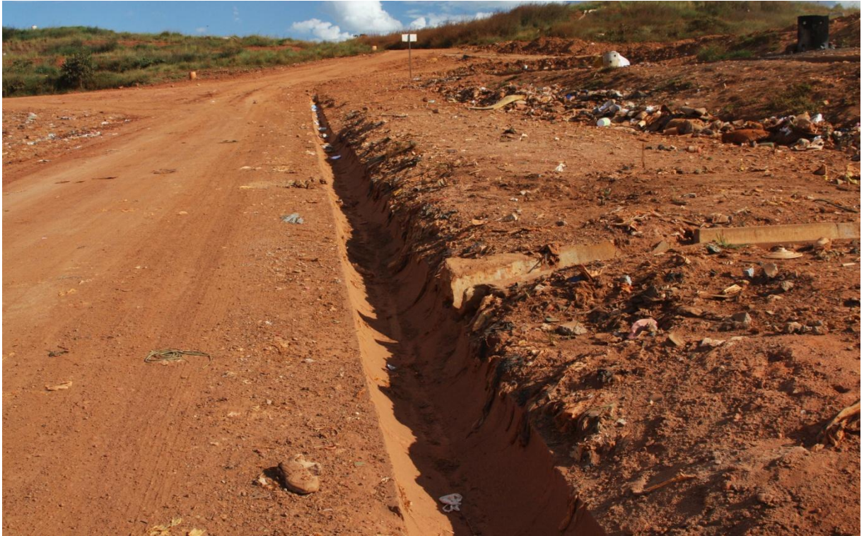
Figura 19: Via de acesso interno do Aterro Sanitário de Anápolis Estado de Goiás. Fonte: Elaborado pela autora (2011).
