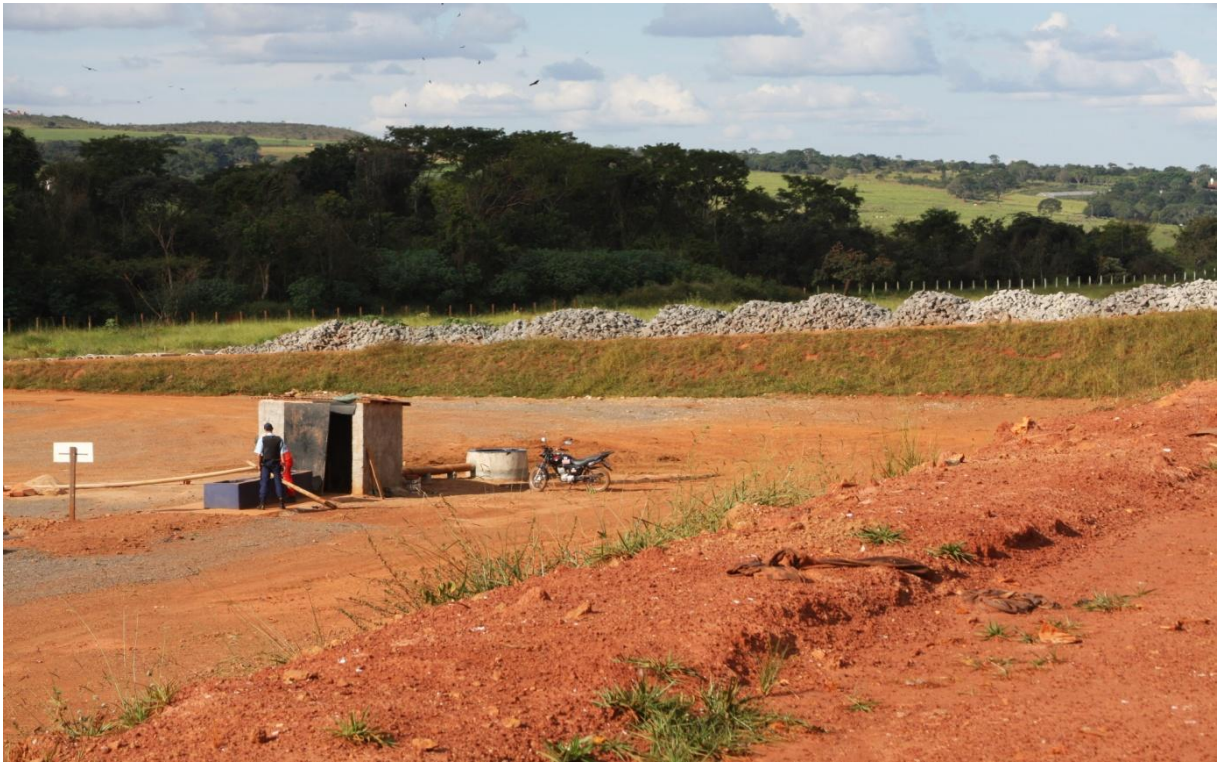
Figura 24: Estoque de Pedras e poço de monitoramento do chorume do Aterro Sanitário de Anápolis Estado de Goiás.
