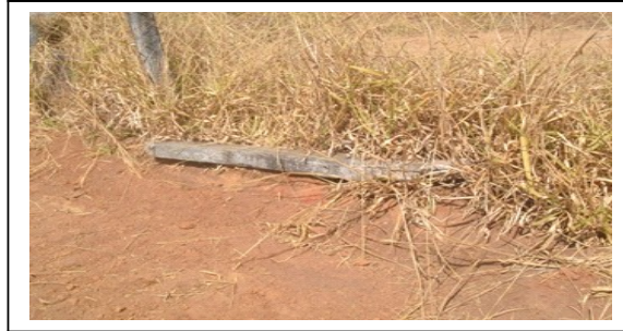
Figura 11 - Cerca danificada no PETO
