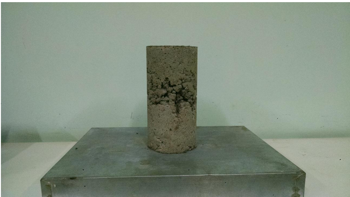
Figura 39 – Falha de adensamento – Amostra 2
