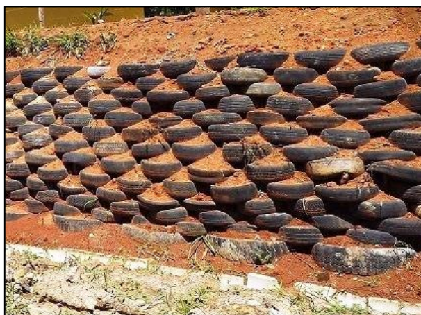
Figura 8 – Muro de arrimo de pneus
