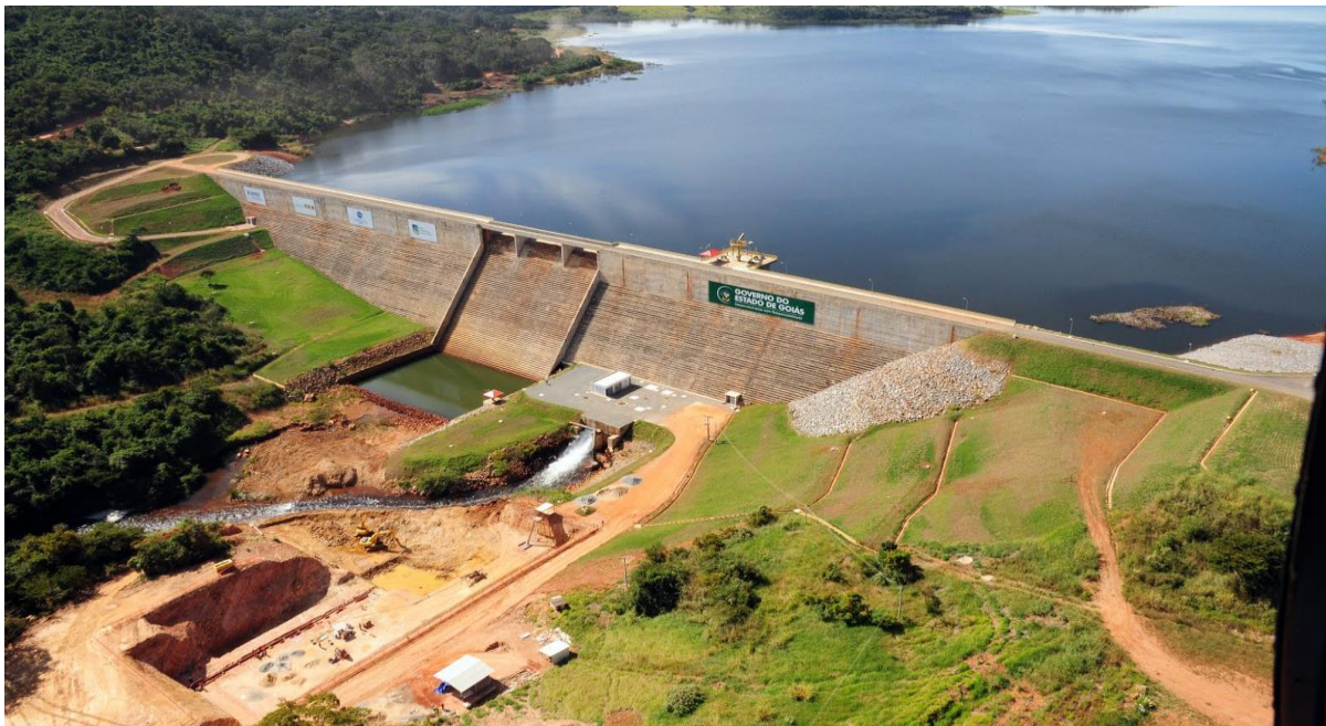
Figura 1: Barragem do Ribeirão João Leite no município de Goiânia - GO
