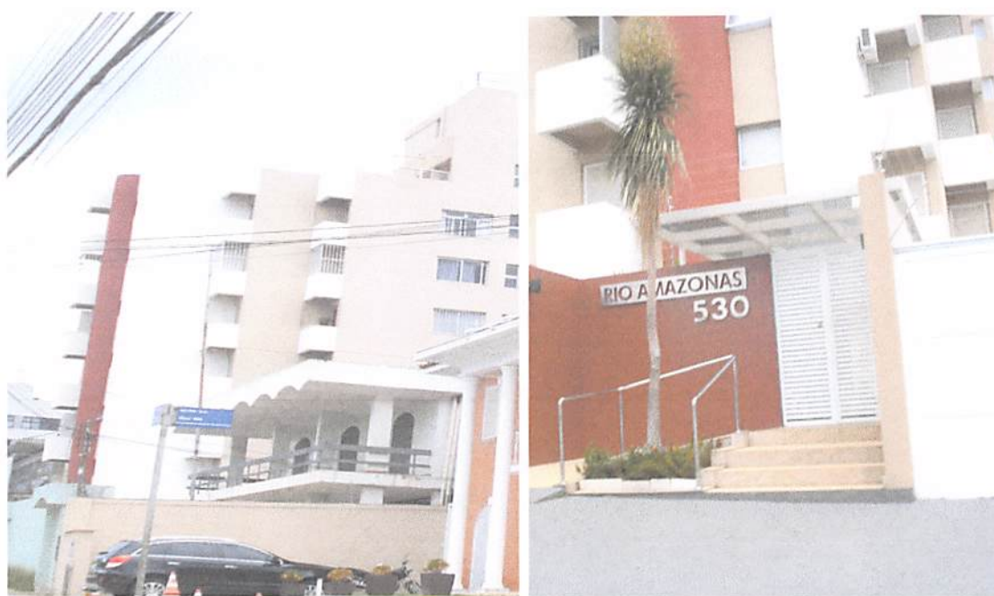
Figura 2.39 - Edifício Rio Amazonas: Alguns Pontos de carga Reforçados
