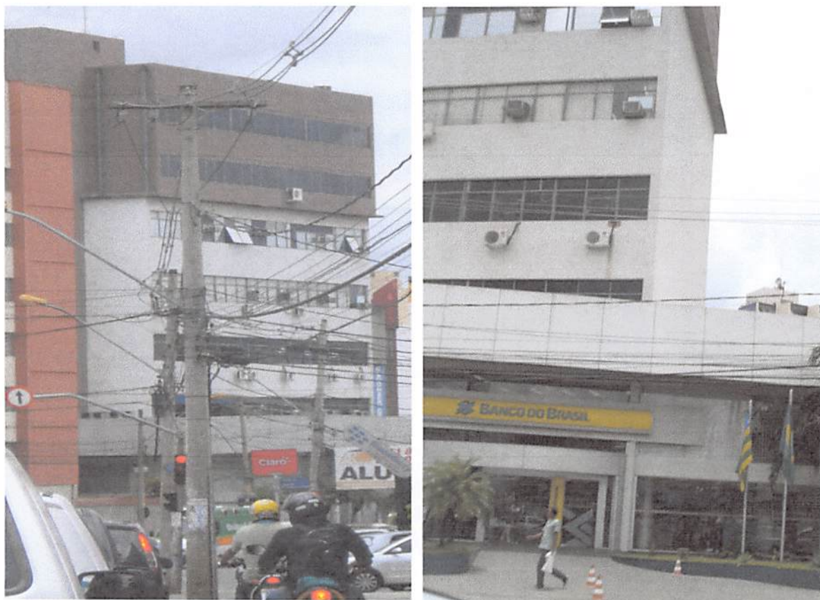
Figura 2.41 - Edifício Comercial: Fundação em Estaca Pré-Moldada
