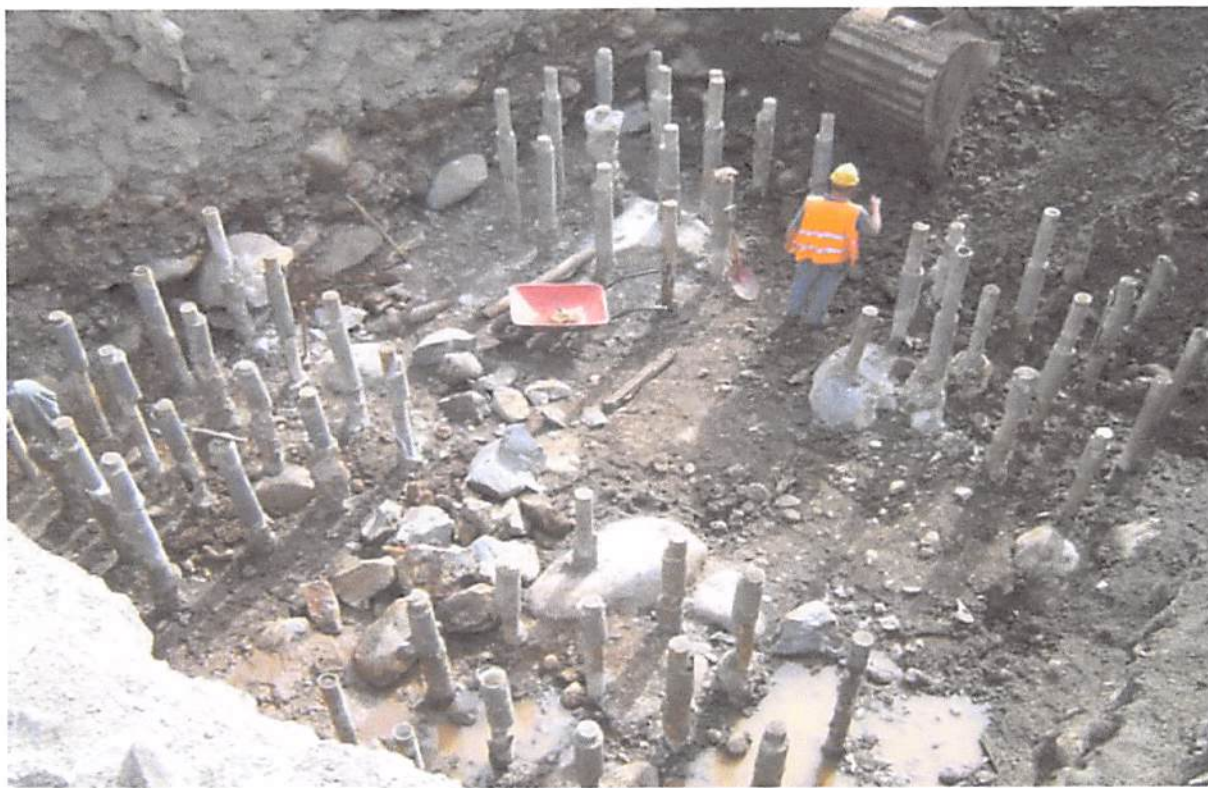
Figura 2.21 – Microestacas Fonte: PRADO; FARIA; VAZ, (2001)
