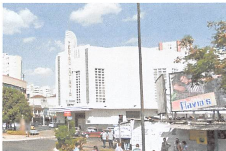
Figura 2.38 – Teatro Goiânia: Reforço de Fundações
