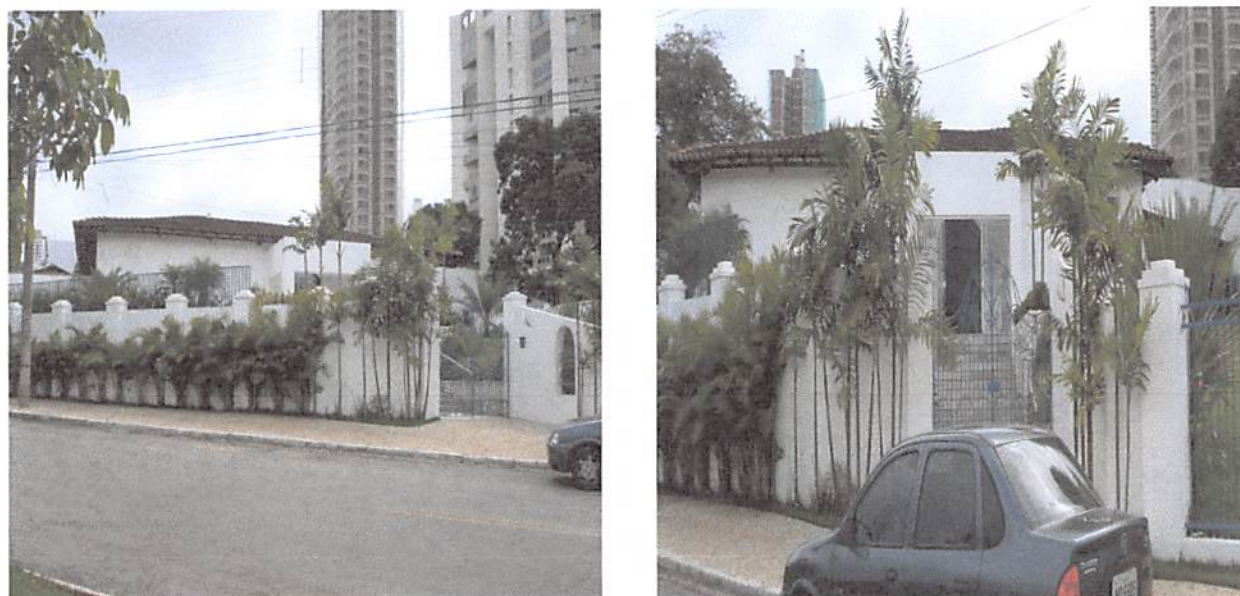
Figura 2.35 – Residência: Reforço em Estaca Mega
