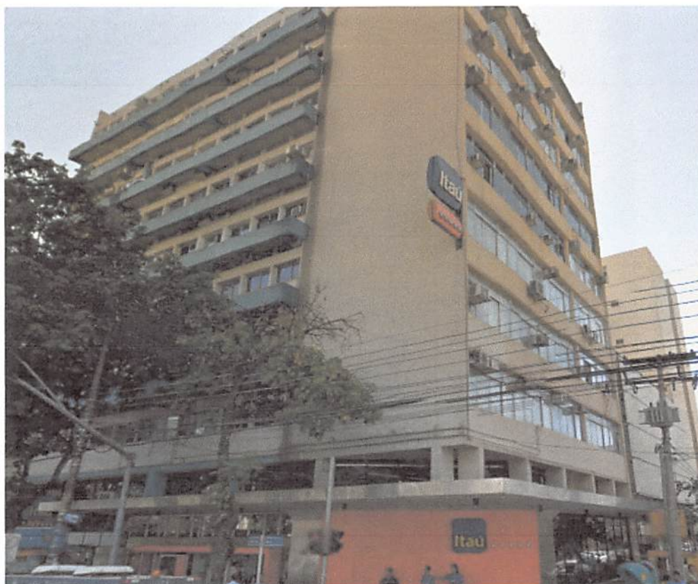
Figura 2.37 – Banco Itaú: Acréscimo de dois Pilares para Acessibilidade
