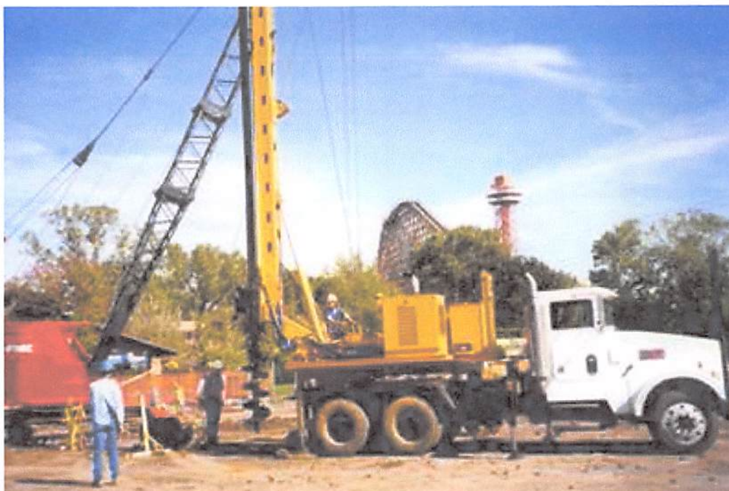
Figura 2.20 – Equipamento de Estaca Escavada Fonte: PRADO; FARIA; VAZ, (2001)
