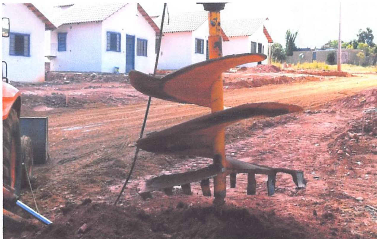
Figura 3.15 - Processo de escavação da fossa
