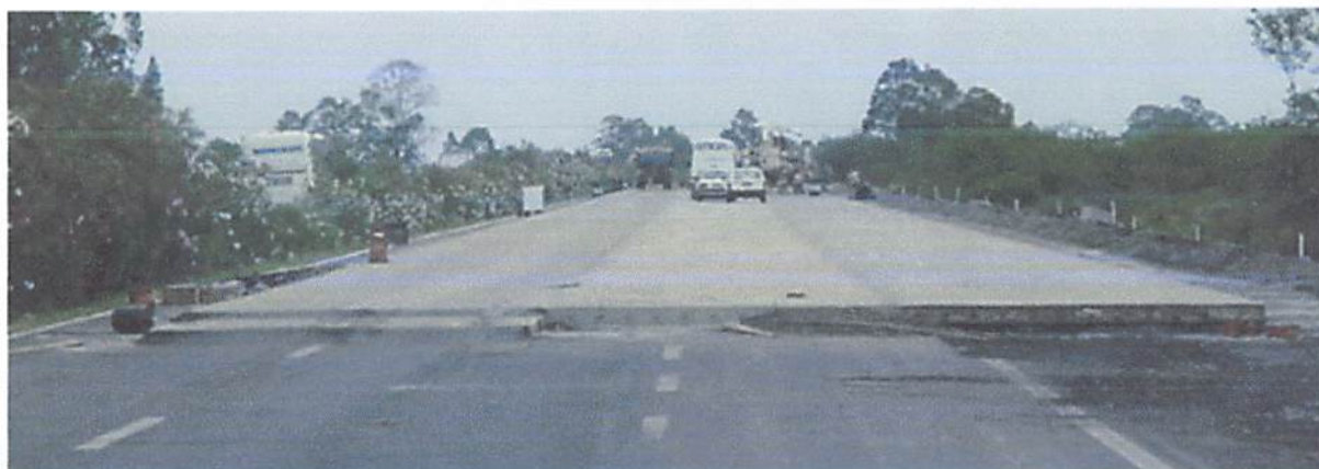
Figura 2.26 - Aplicação da Técnica Whitetopping sobre o pavimento flexível
