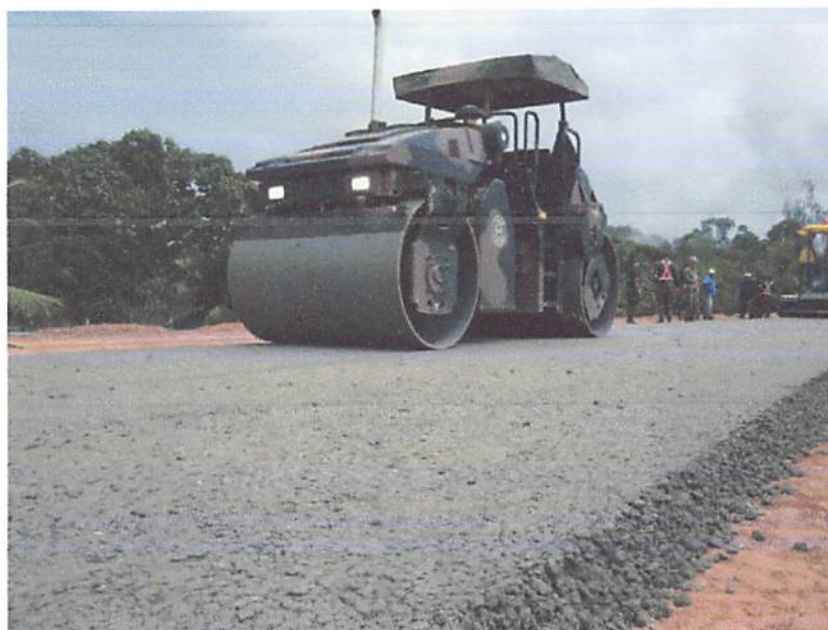
Figura 2.23 - Concreto compactado com Rolo
