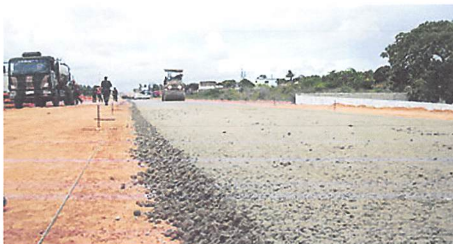
Figura 2.22 - Lançamento de concreto a ser compactado com rolo
