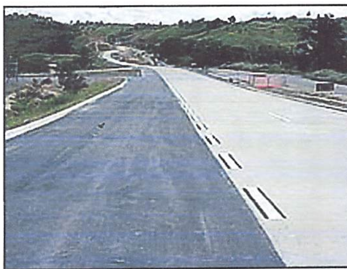
Figura 2.14 - Via pavimentada de concreto de cimento Portland (CCP) (Fonte: ABCP)
