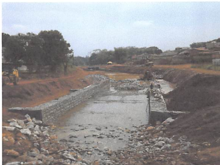
Figura 2.3 – Construção de Marginal – Central Parque da Anápolis-GO (CIDADE DE ANÁPOLIS,2013).
