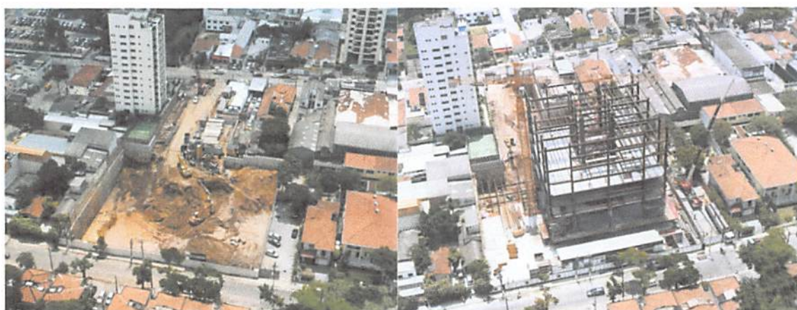
Fig. 10.3: Utilização do steel deck na construção do Edifício New Century. Fonte: Método Estruturas (2013)
