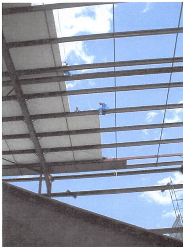
Fig.7.9: Montagem da telha steel deck . Fonte: o autor (2013)
