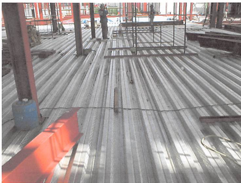
Fig.7.18: Montagem e fixação dos acabamentos. Fonte: o autor (2013)
