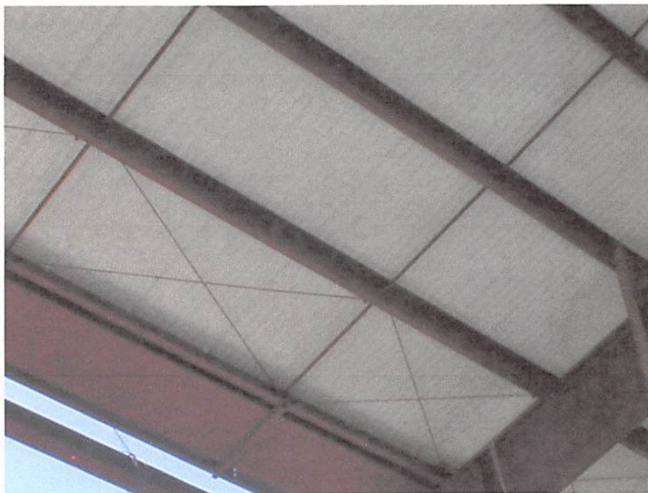
Fig. 7.15: Fixação da telha sobre a terço Z. Fonte: o autor (2013)
