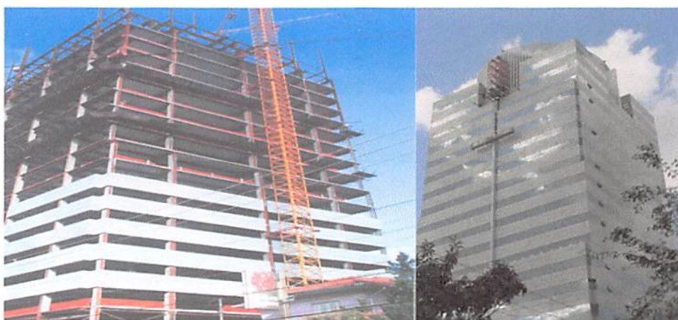
Fig. 10.4: Utilização do steel deck na construção do Edifício New Century. Fonte: Método Estruturas (2013)
