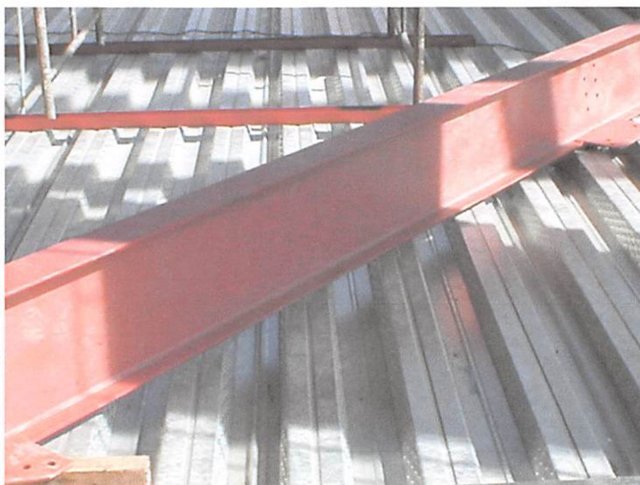
Fig. 7.16: Montagem e fixação dos acabamentos. Fonte: o autor (2013)
