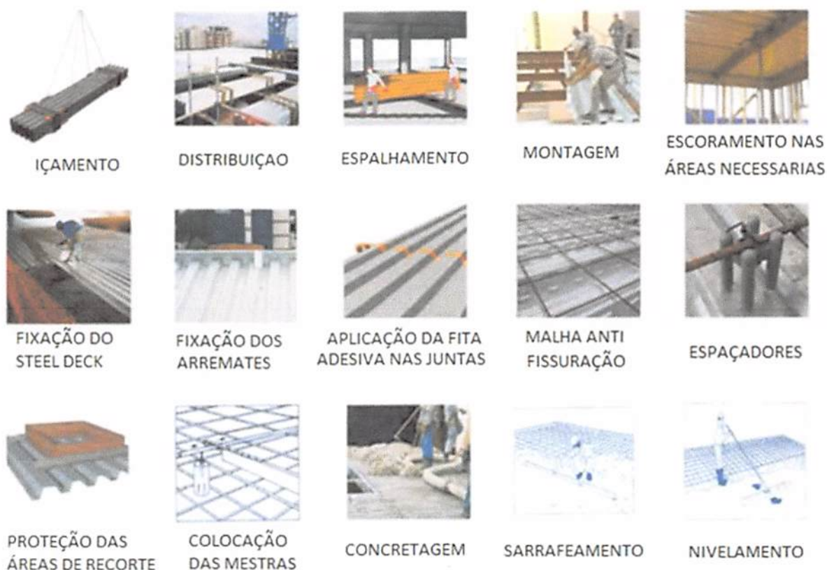
Fig. 7.2: Etapas da utilização do steel deck . Fonte: Silva (2010)
