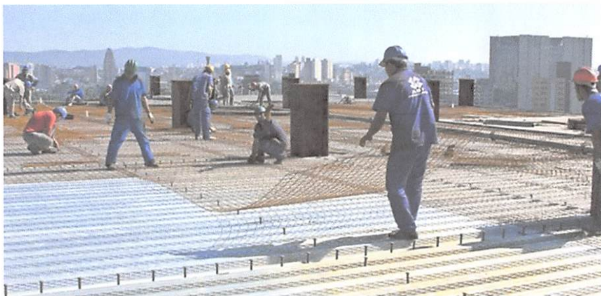
Fig. 7.11: Colocação de malha antifissuração. Fonte: Equipe de Obras (2013)
