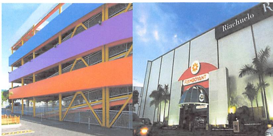
Fig. 10.7: Utilização do steel deck no Shopping Flamboyant – Goiânia/GO. Fonte:Portal Metálica (2013).
