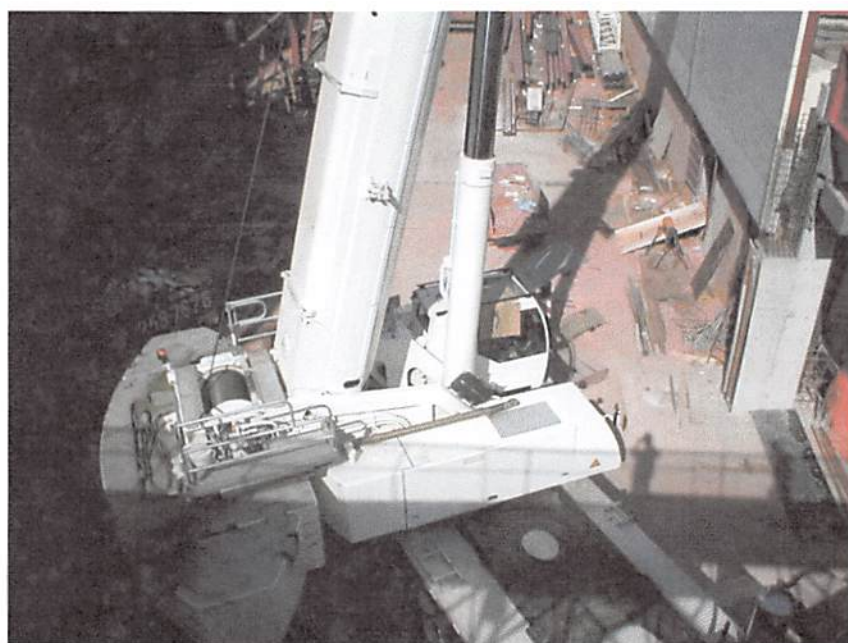
Fig. 7.24: Preparação para a concretagem. Fonte: o autor (2013)
