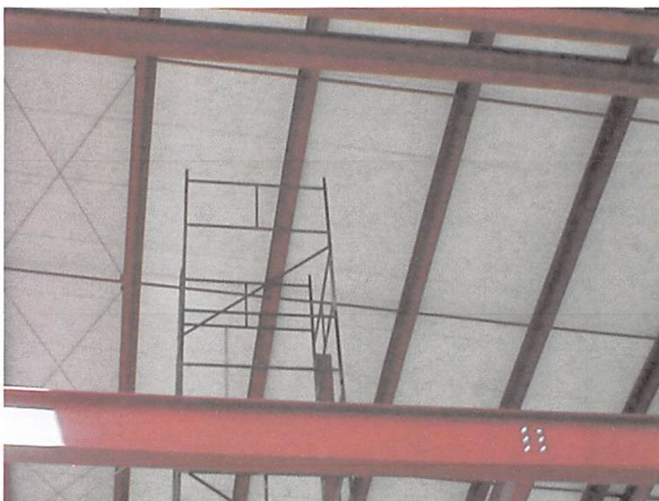
Fig. 7.22: Preparação para a concretagem. Fonte: o autor (2013)
