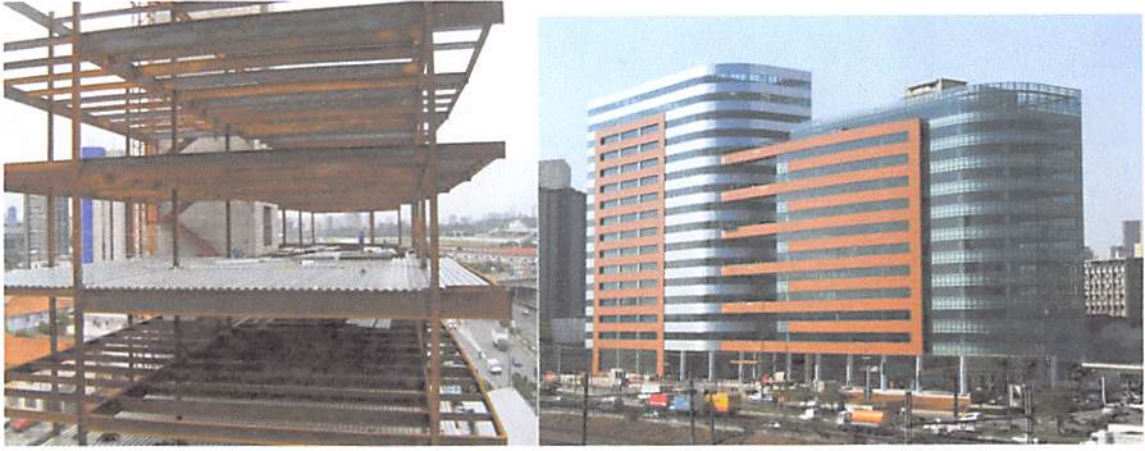
Fig. 10.2: Utilização do steel deck na construção do Edifício WTorre Nações Unidas. Fonte: WTorre (2013)
