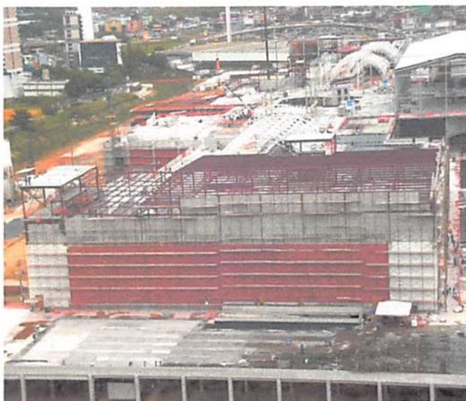
Fig. 10.5: Utilização do steel deck na construção do Salvador Shopping. Fonte: Portal Metálica (2013)
