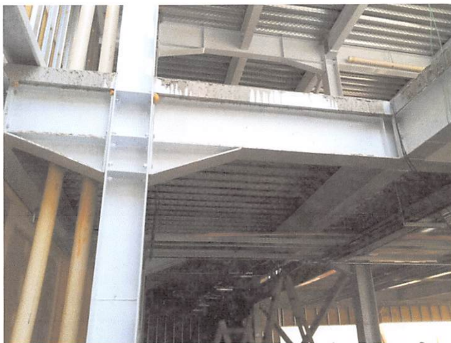
Fig. 8.4: Montagem da laje steel deck no Hospital Premium. Fonte: o autor (2013)
