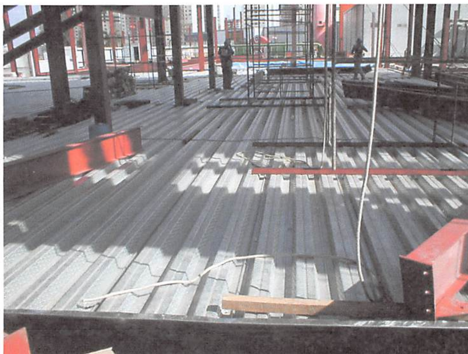
Fig.7.17: Montagem e fixação dos acabamentos. Fonte: o autor (2013)
