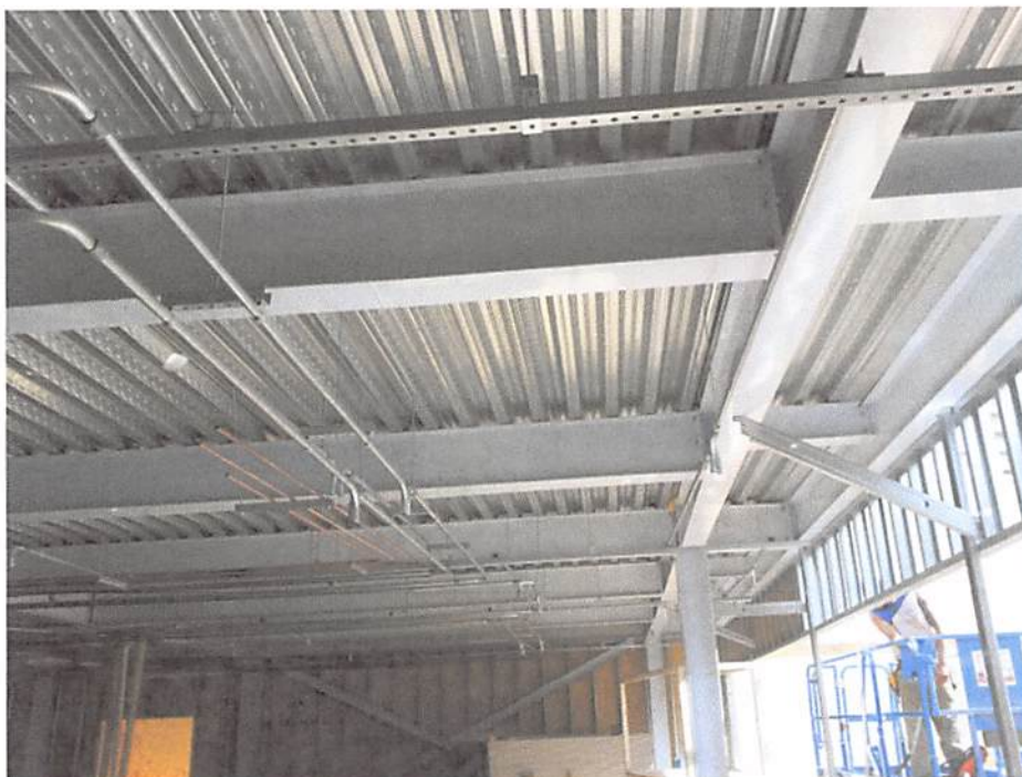
Fig. 8.2: Montagem da laje steel deck no Hospital Premium. Fonte: o autor (2013)
