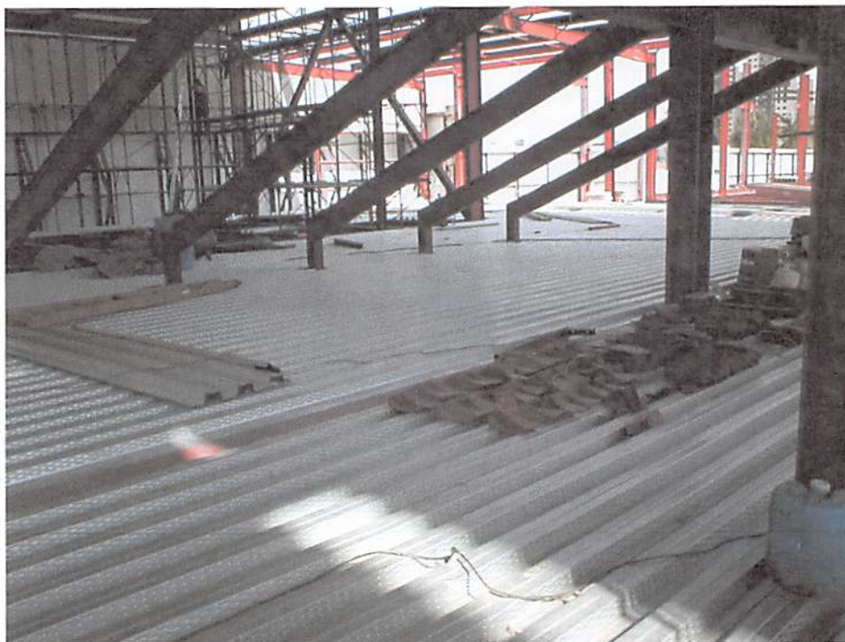
Fig.7.19: Montagem e fixação dos acabamentos. Fonte: o autor (2013)
