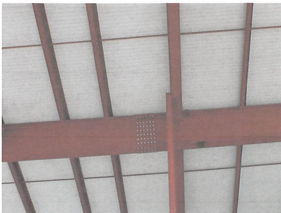
Fig. 7.14: Fixação da telha sobre a terço Z. Fonte: o autor (2013)
