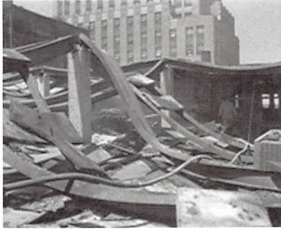
Fig. 11.1: Vigas do 6º andar do Edifício Bressmer após incêndio em 1948, Springfield, EUA.
