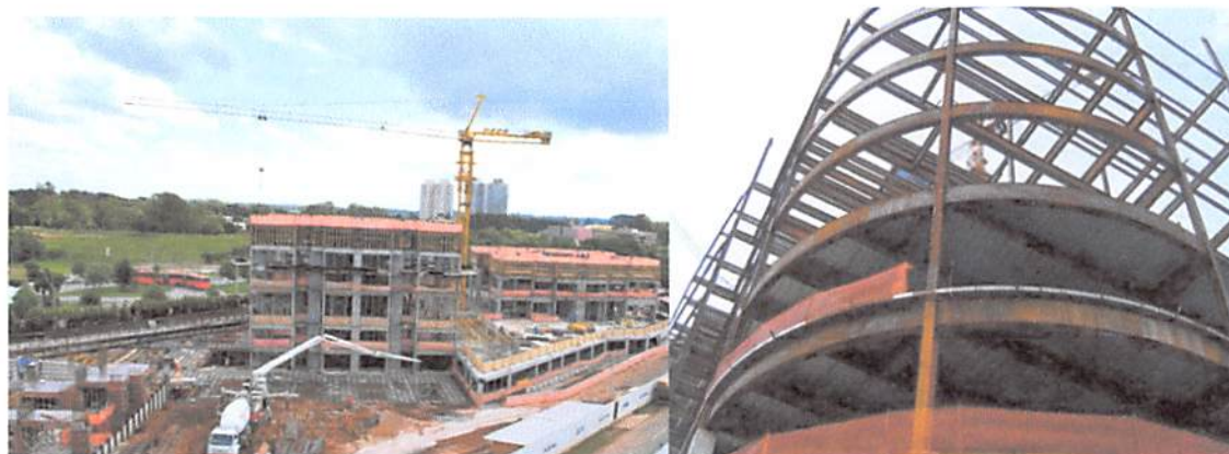
Fig 10.1: Utilização do steel deck na construção do Edifício WTorre Nações Unidas. Fonte: Wtorre (2013)
