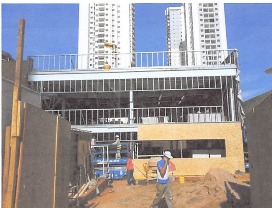
Fig. 8.1: Montagem da laje steel deck no Hospital Premium. Fonte: o autor (2013)
