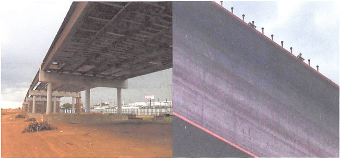
Fig. 10.8: Utilização dos conectores de cisalhamento stud bolts no Viaduto do DAIA – Anápolis-GO
