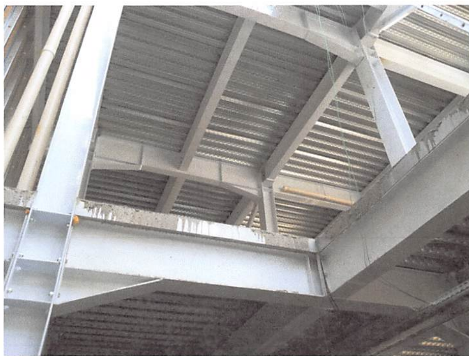
Fig. 8.5: Montagem da laje steel deck no Hospital Premium. Fonte: o autor (2013)
