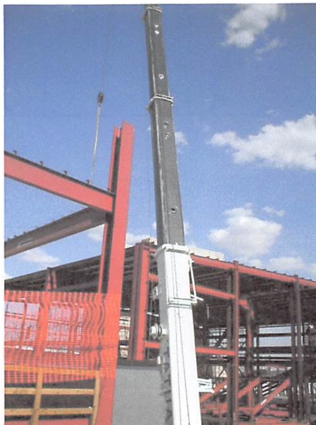
Fig. 7.3: Içamento - distribuição e espalhamento. Fonte: o autor (2013)
