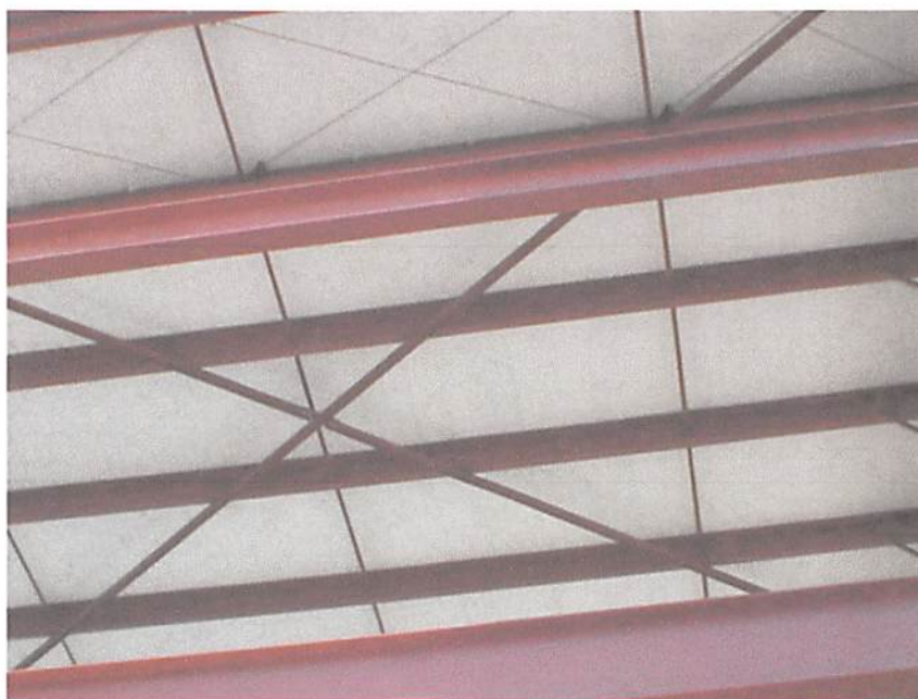
Fig.7.10: Montagem da telha steel deck . Fonte: o autor (2013)
