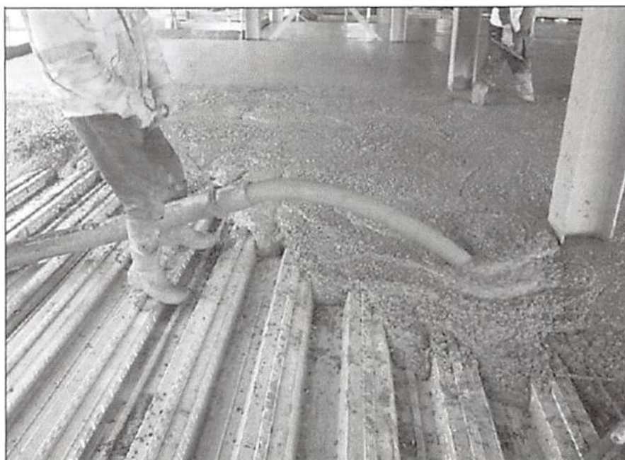
Fig. 7.25: Bombeamento de concreto reforçado com fibras. Fonte: Rackham et al. (2009)
