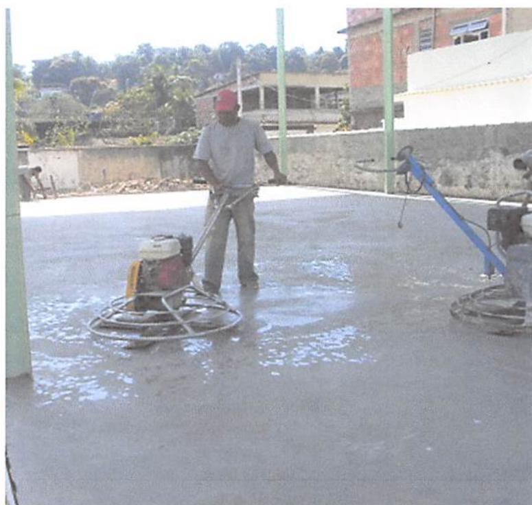
Fig. 7.28: Nivelamento do concreto. Fonte: B & C Pavimentações de Concreto (2013)
