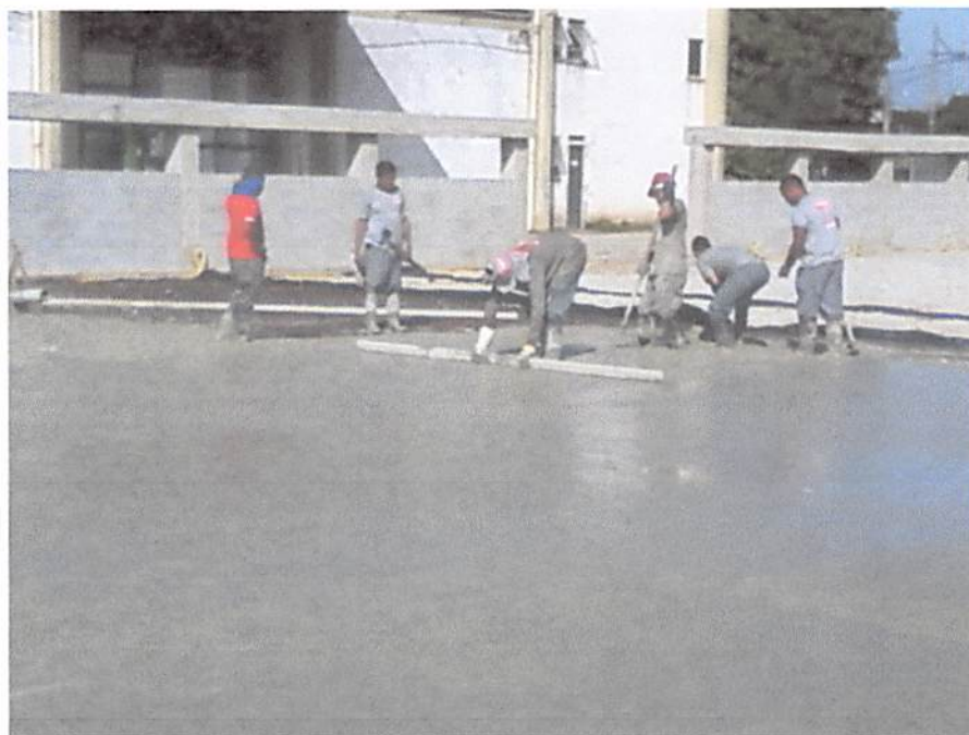
Fig. 7.27: Sarrafeamento do concreto. Fonte: B & C Pavimentações de Concreto (2013)
