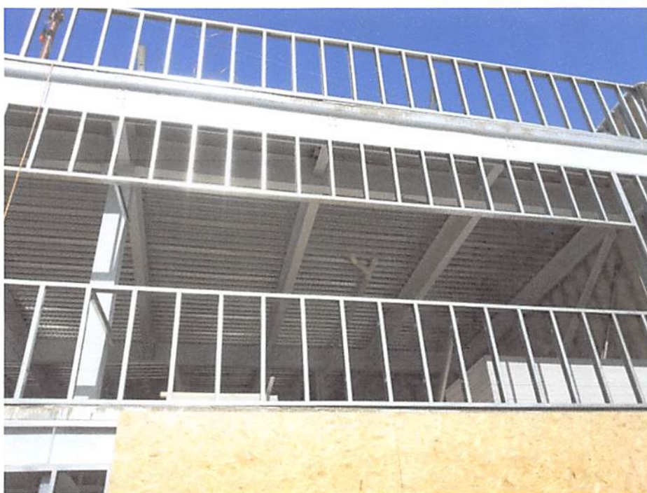
Fig. 8.3: Montagem da laje steel deck no Hospital Premium. Fonte: o autor (2013)
