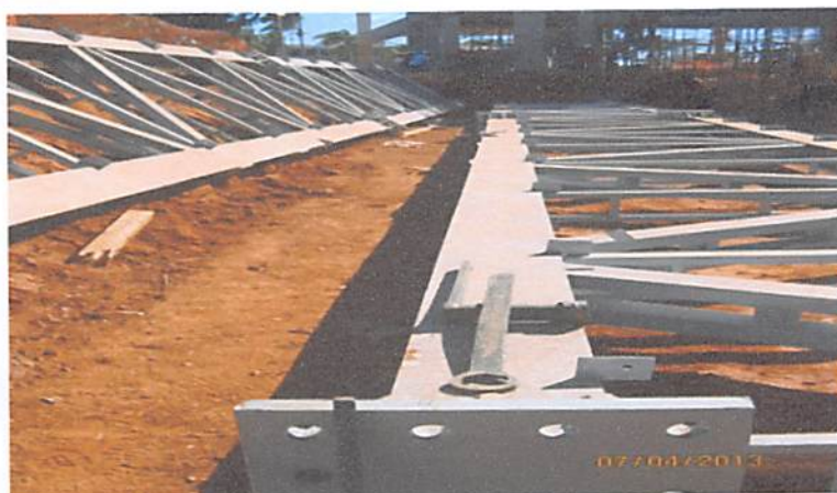
Fig.4.6 – Montagem da estrutura Fonte: Pontes Construtivas metálicos
