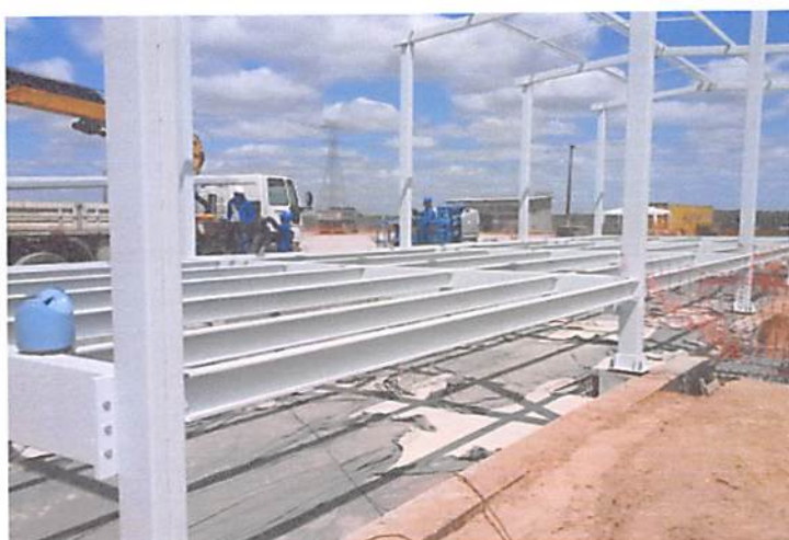
Fig. 4.1– Montagem de estrutura Fonte: Pontes Construtivos metálicos
