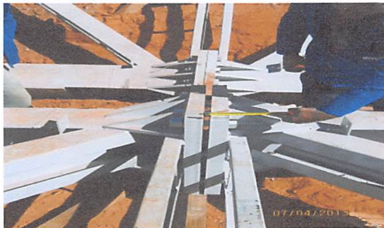
Fig. 4.5 – Montagem da estrutura Fonte: Pontes Construtivas metálicos
