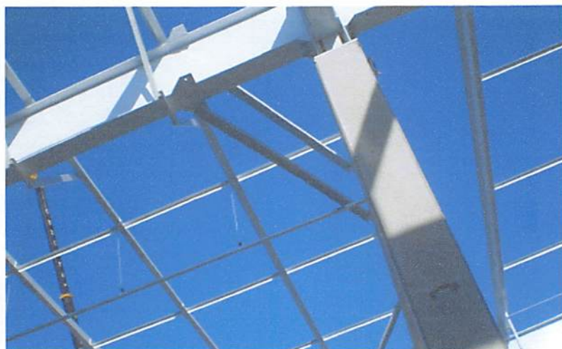
Fig.4.8 – montagem da estrutura Fonte: Pontes Construtivas metálicos
