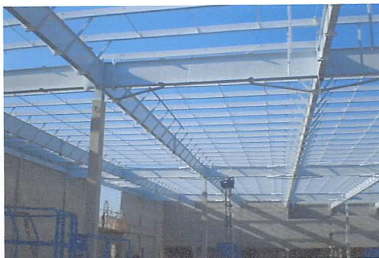
Fig. 4.7 – Montagem da estrutura Fonte: Pontes Construtivas metálicos
