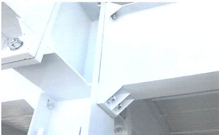
Fig. 4.2 – Montagem de estrutura Fonte: Pontes Construtivas metálicos
