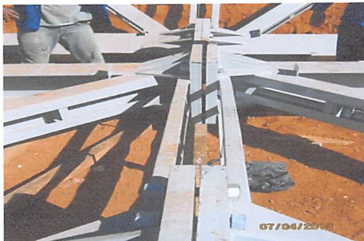
Fig. 4.4 – Montagem de estrutura Fonte: Pontes Construtivas metálicos
