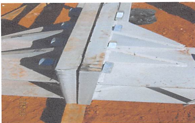
Fig. 4.3 – montagem de estrutura Fonte: Pontes Construtivas metálicos
