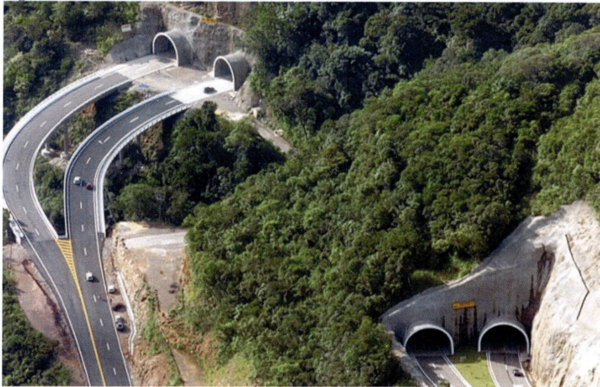
Figura 2 – Túneis Rota do sol TB
