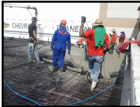
Figura 14 - Bombeamento do Concreto
