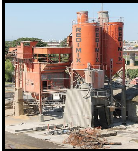
Figura 7 - Equipamentos da Concreteira
