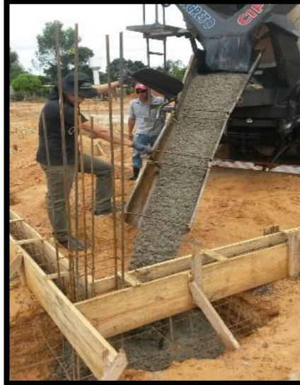
Figura 13 - Lançamento do Concreto
