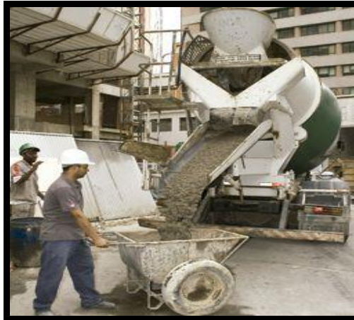
Figura 10 - Recebimento Concreto na Obra
