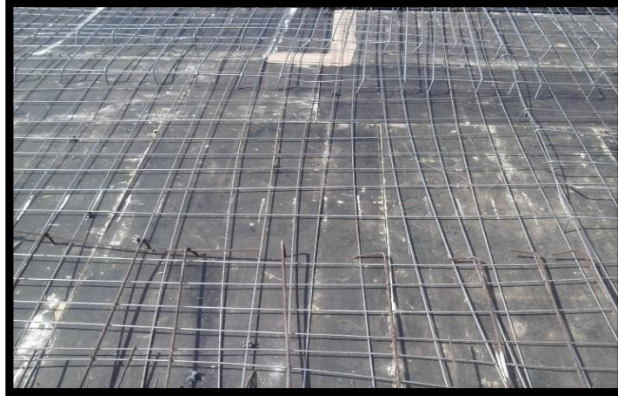
Figura 9 - Armaduras Positivas e Negativas
