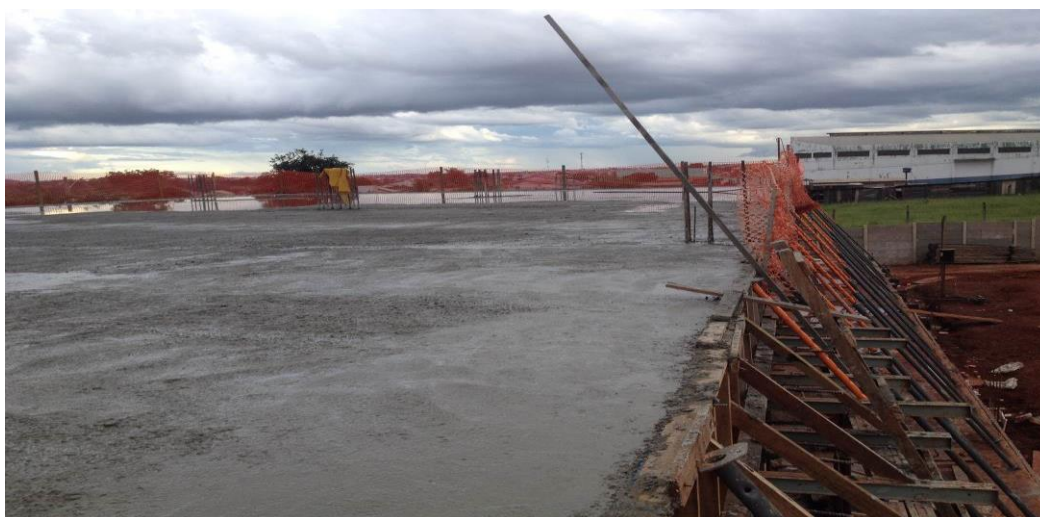
Figura 26 - Cura da laje
