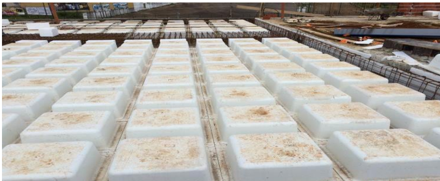
Figura 11 - Montagem de uma laje nervurada com cubas plásticas
