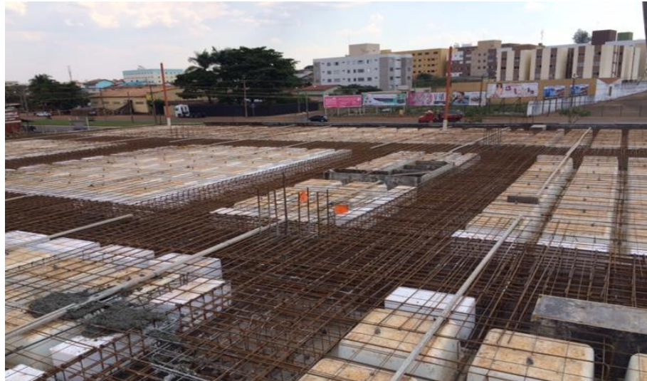
Figura 20- Laje com vigas-faixas
