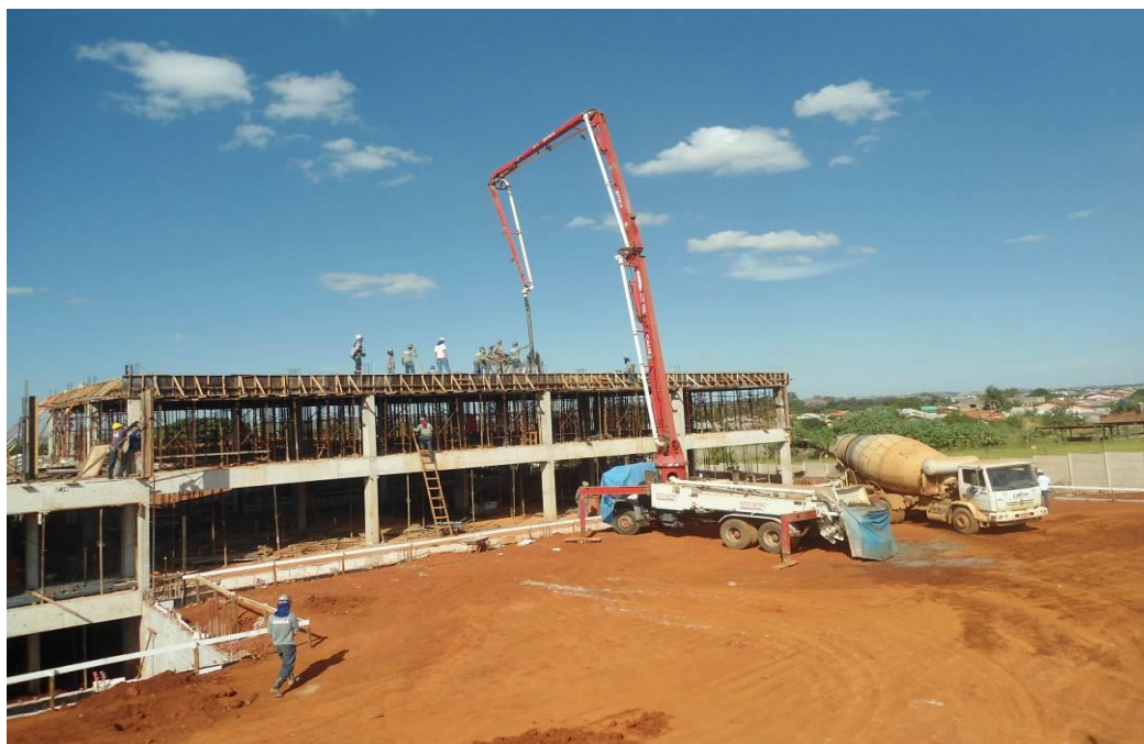
Figura 24 - Lançamento do concreto
