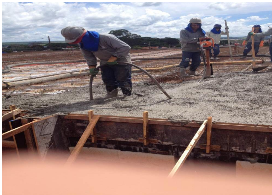
Figura 25 - Adensamento do concreto
