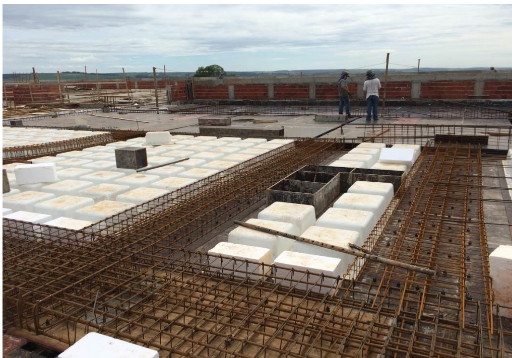
Figura 5- Laje com vigas-faixa
