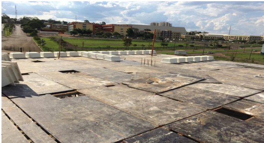
Figura 16- Forro da Laje
