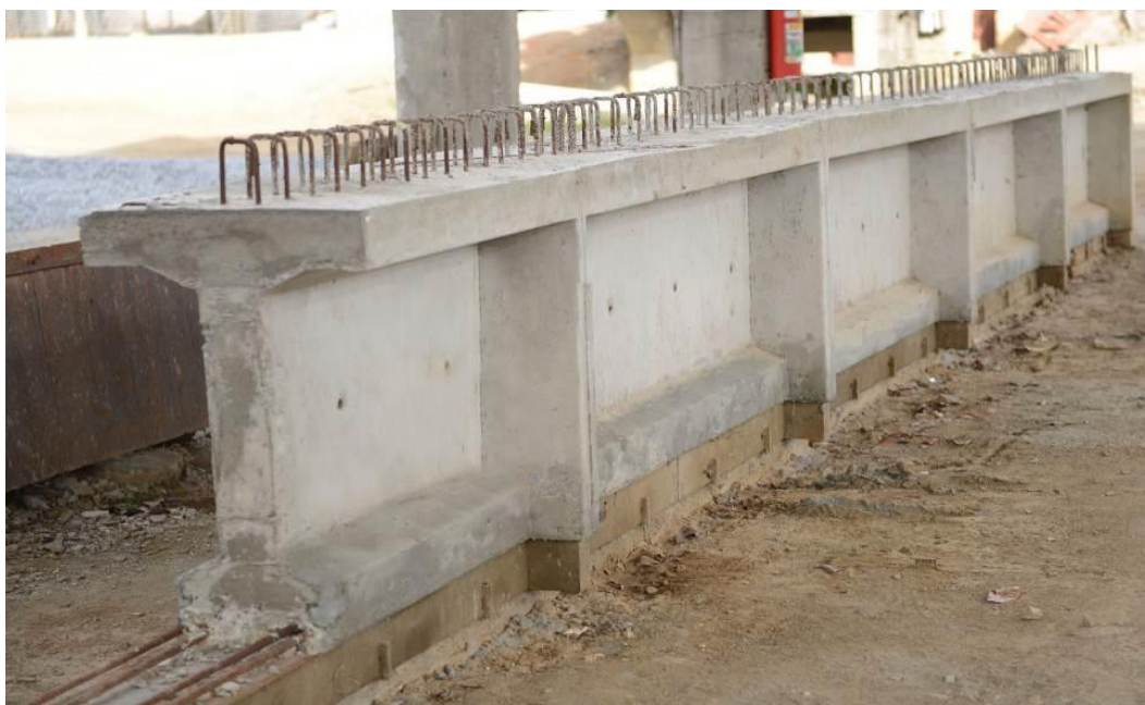
Figura 6 - Viga de concreto armado
