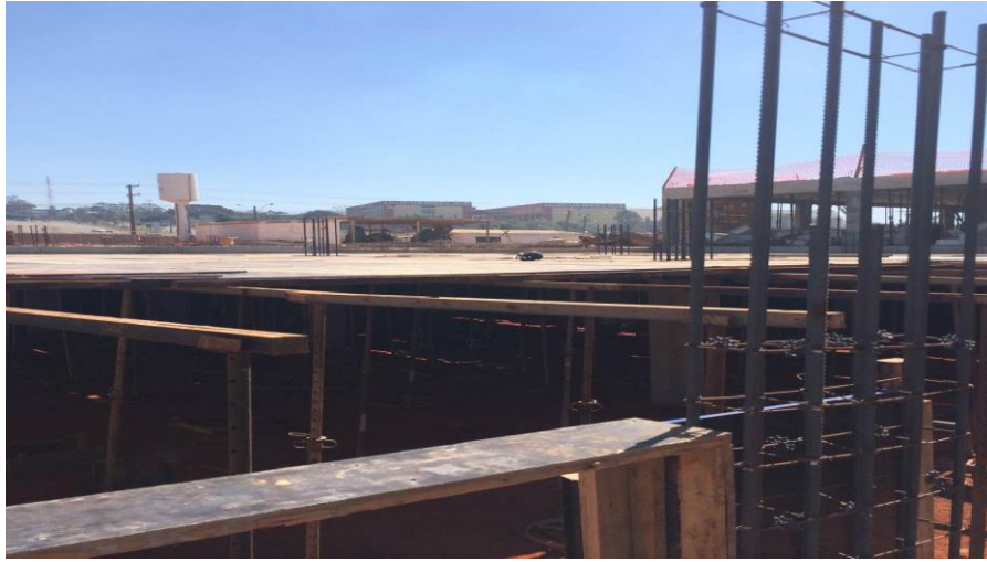
Figura 15- Escoramento da laje
