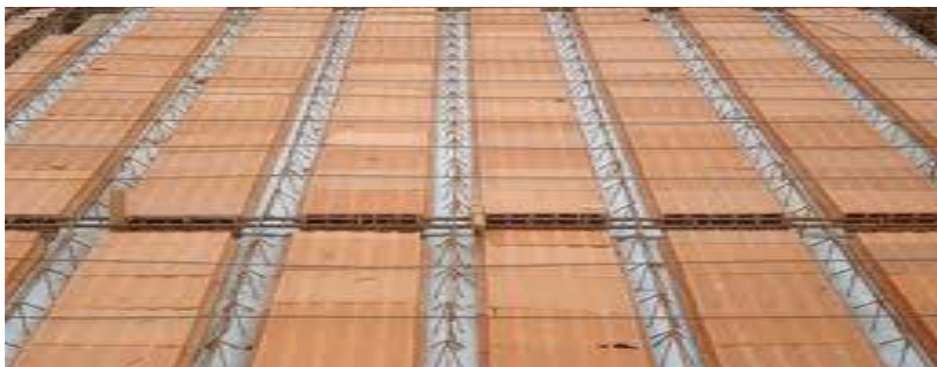
Figura 9- Laje nervurada como blocos cerâmicos
