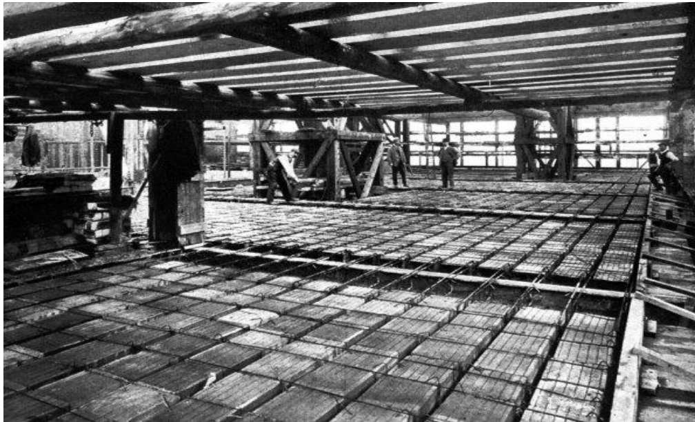
Figura 2 – Imagem da primeira laje nervurada registrada
