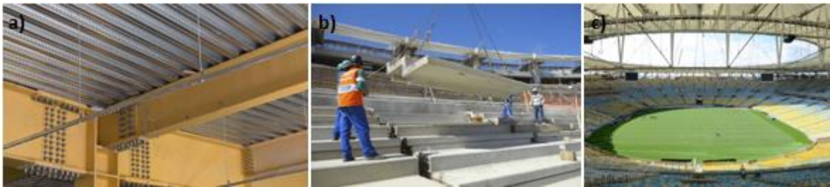
Figura 1- Utilização do concreto leve na reforma do Estádio Maracanã (2010-2013). a) sistema de lajes Steel Deck b) degraus da arquibancada de concreto leve pré-moldado e c) Estrutura montada
