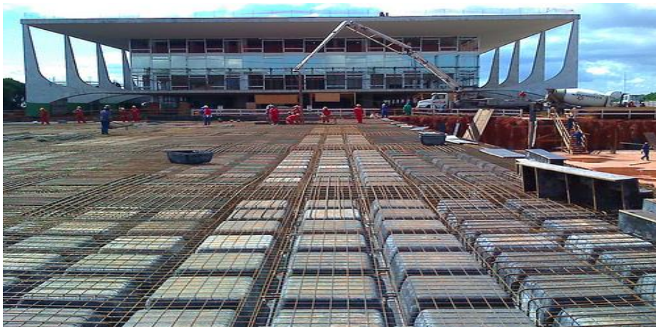
Figura 15. Cubetas espalhadas sobre painel de laje nervurada
