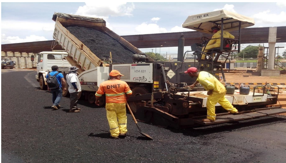
Figura 17- Acabadora de asfalto
