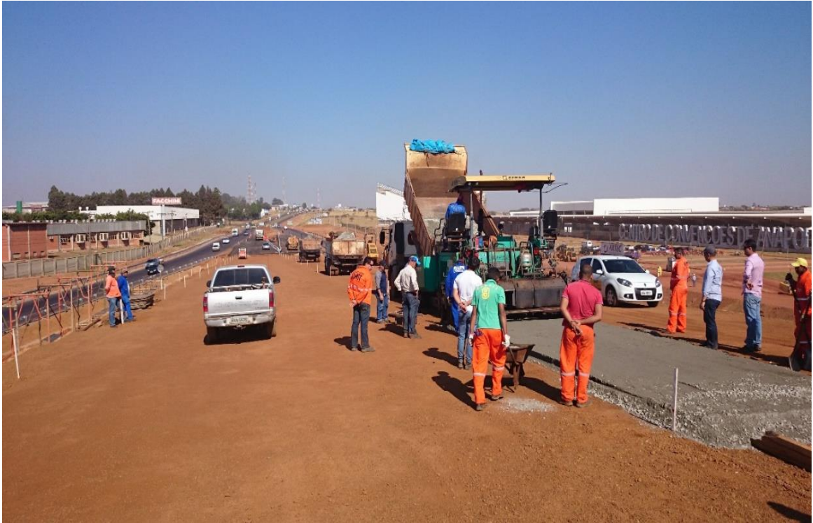
Figura 20- Execução de Sub-base de concreto rolado
