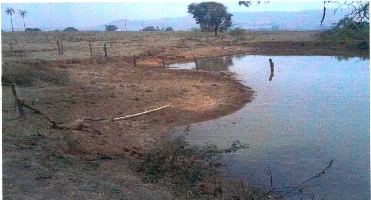
Reservatório, construído e destruído pela irrigação de cana-de-açúcar. Fonte: Foto tirada pela autora, 2009.
