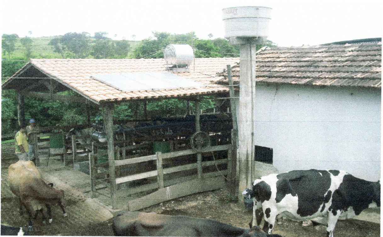
Foto 11 – Sistema de energia solar para lavagem da ordenhadeira.
