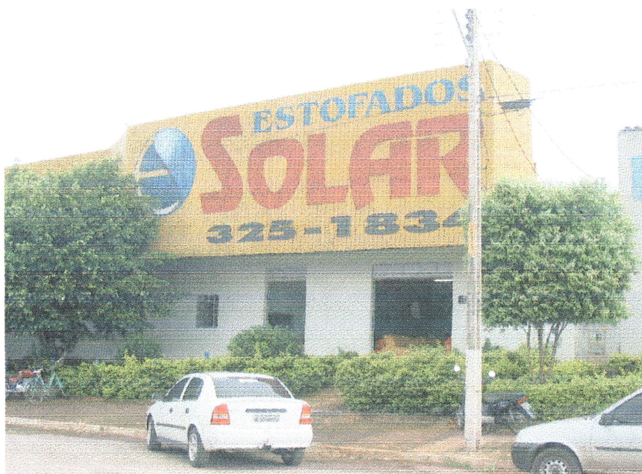
Figura 01: Fachada da empresa “Estofados Solar”.
