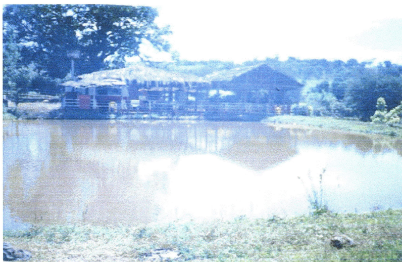
Figura 4: Estrutura do chalé, juntamente com os tanques de pesca.
