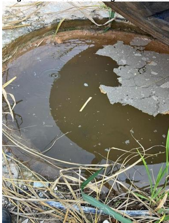
Figura 3 – 2º reservatório água decantada
