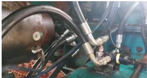
Figura 7: Válvulas instaladas no britador
