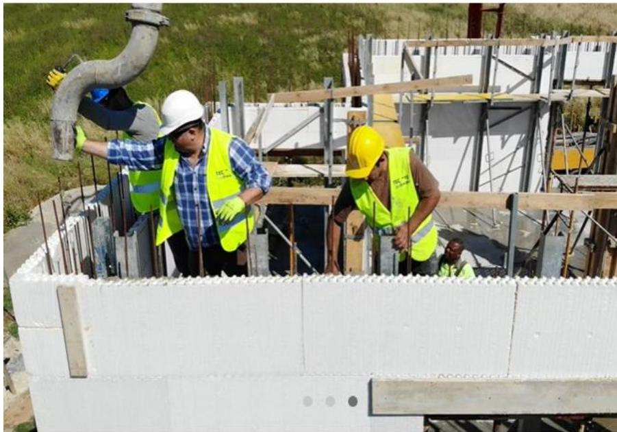
**Figura 5** - Concretagem das paredes EPS (TEC DREAM, 2022)
