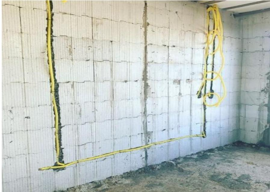
**Figura 9:** Instalação do eletroduto corrugado na parede de EPS. (JESUS E BARRETO, 2018)
