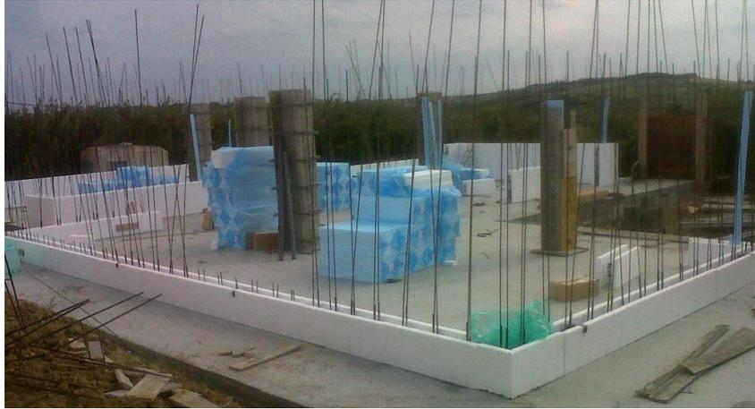
**Figura 3:** Fundação do tipo radier com esperas de aço e blocos de EPS. (Termo Box, 2014)
