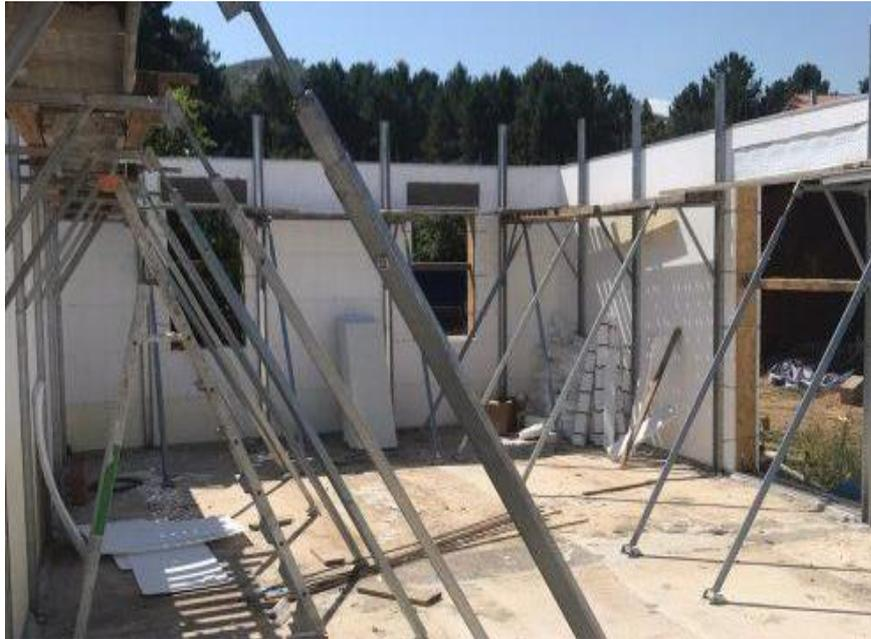
**Figura 7:** Instalação de Aprumadores (Termo Box, 2020)
