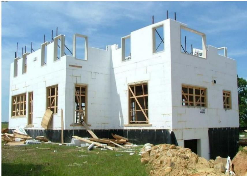
**Figura 6:** Abertura de esquadrias e Impermeabilização (ISOCRET, 2021)
