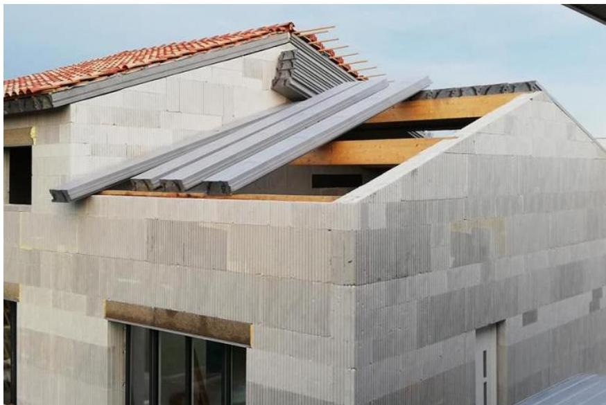
**Figura 8:** Instalação da cobertura sobre as paredes de EPSs. (FÓRUM DA CASA, 2019)
