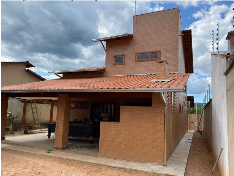
Figura 06: Construção em tijolo solo-cimento em fase final de construção
