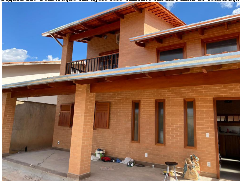
Figura 12: Construção em tijolo solo-cimento em fase final de construção
