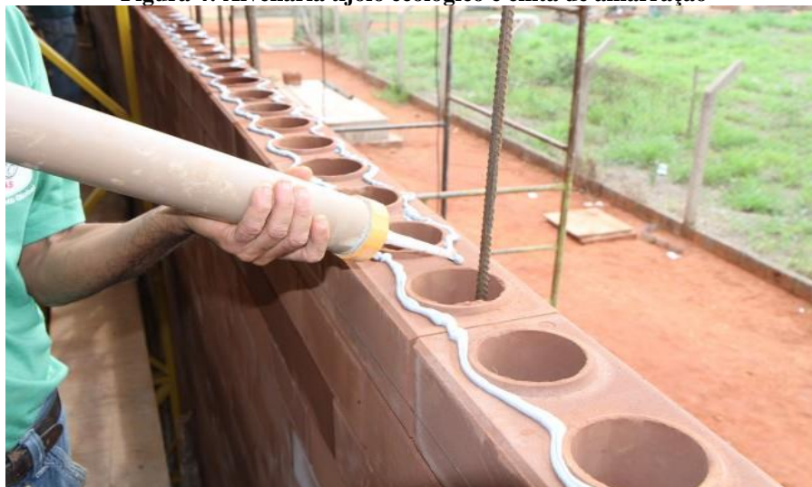
Figura 4: Alvenaria tijolo ecológico e cinta de amarração
