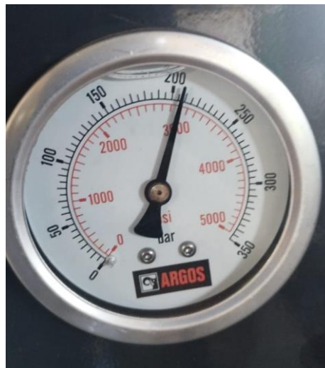
Figura 7 - Teste do sistema hidráulico
