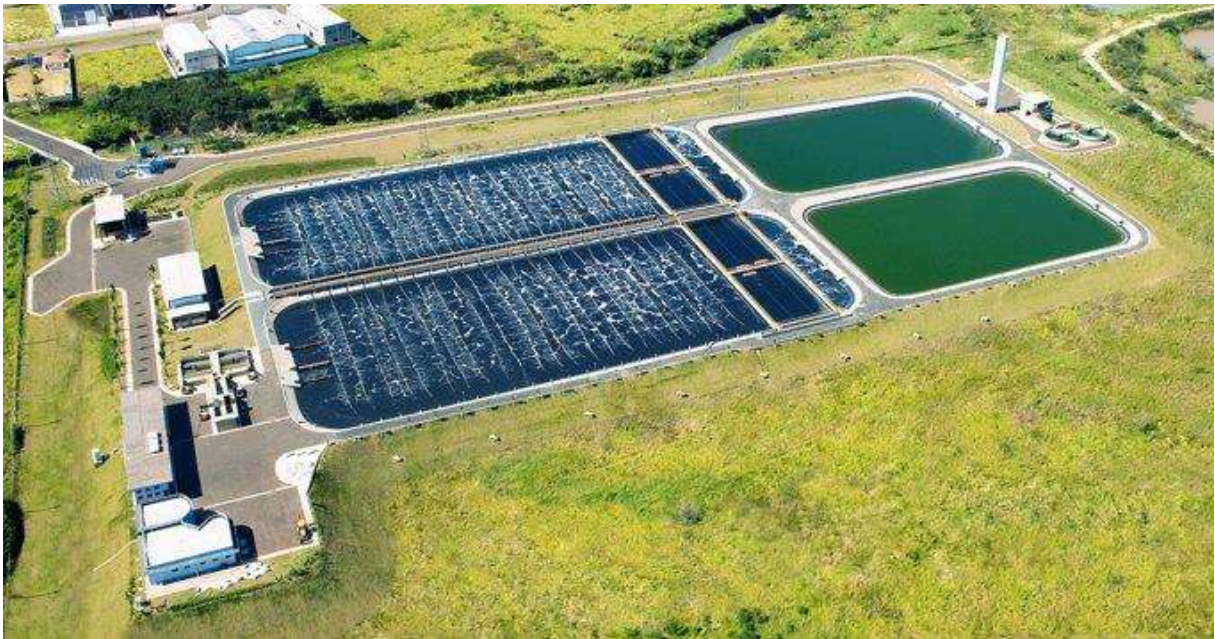
Figura 13 - Estação de Tratamento de Esgoto (ETE) Mário Arnaldo Canadelo
