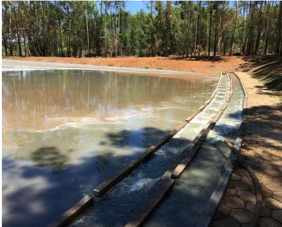
Figura 14 - Lagoa anaeróbica da ETE localizada no DAIA
