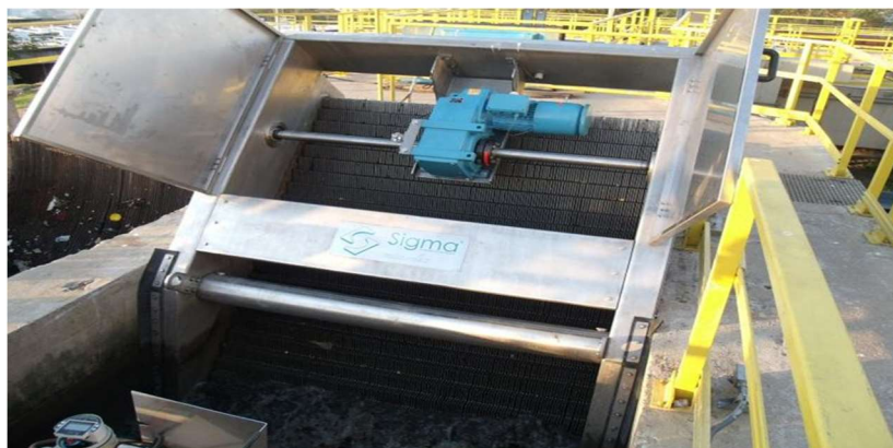
Figura 7 - Gradeamento de Limpeza Mecanizada
