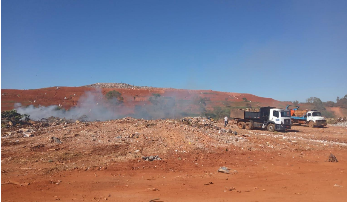
Figura 08 - Descarte de resíduos de construção civil no aterro de Anápolis-GO
