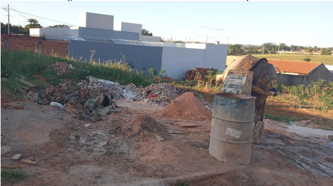
Figura 10 - Descarte indevido de resíduos de construção civil
