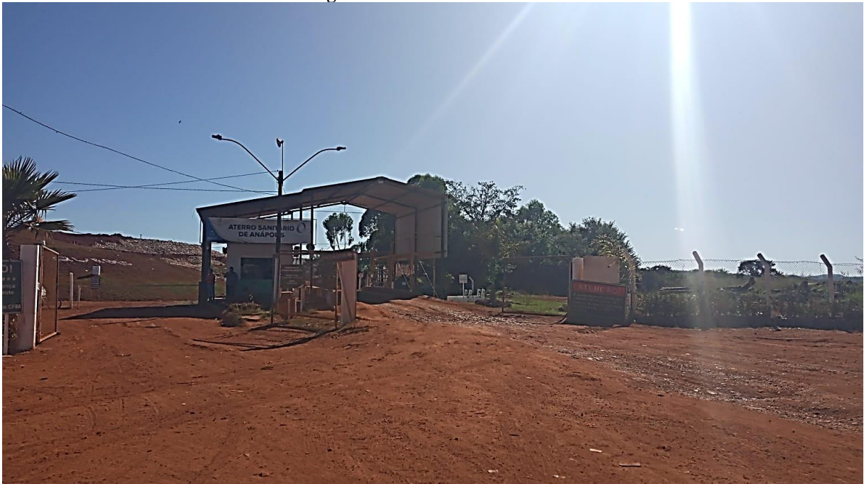
Figura 05 - Entrada do Aterro
