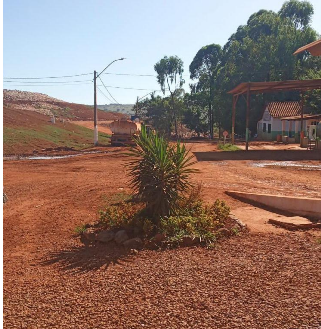
Figura 07 - Estrutura administrativa do aterro de Anápolis-GO
