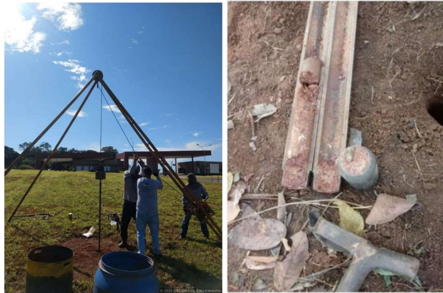
Figura 16 - Execução do ensaio de sondagem: (a) Queda do martelo (b) Amostragem do solo
