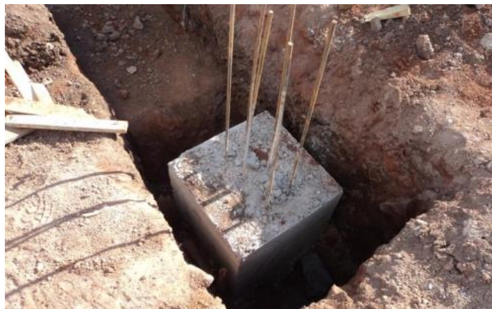
Figura 12 - Bloco de fundação pronto
