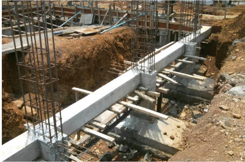
Figura 5 - Sapatas individuais conectadas por uma vigas.
