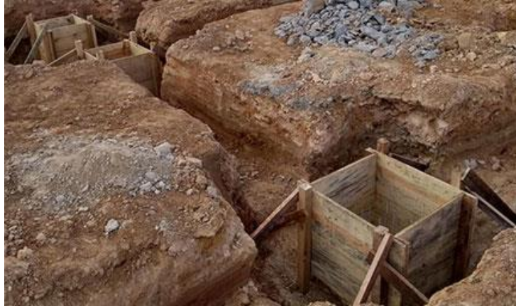
Figura 10 - Locação das formas
