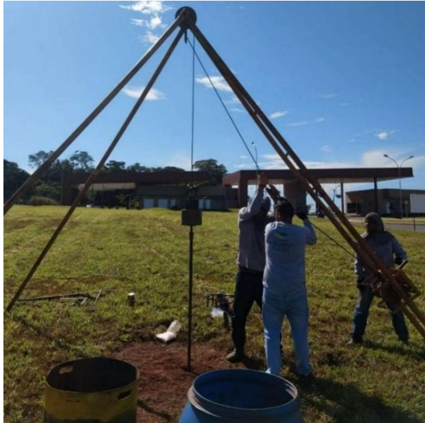
Figura 23 - Execução do Ensaio de Sondagem
