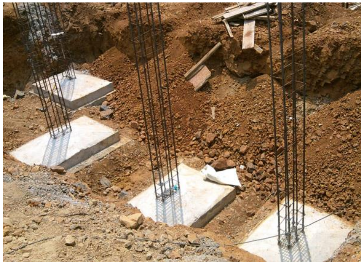
Figura 6 - Sapatas individuais aguardando concretagem do pilar da sapata.
