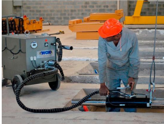
Figura 25– Macaco Hidráulico de Protensão
