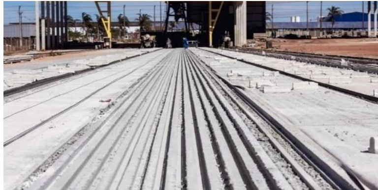
Figura 23 – Pista de laje Protendida.
