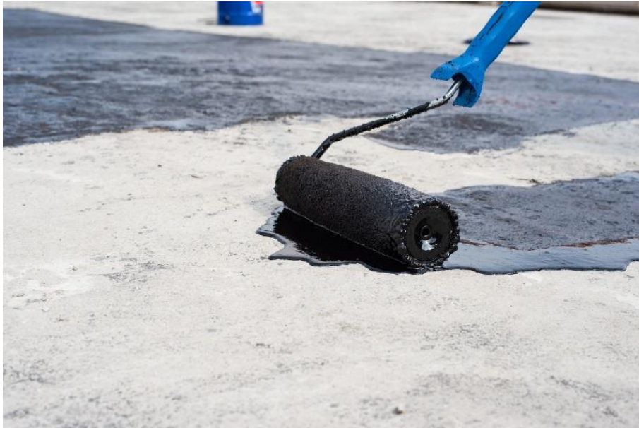
Figura 18– Pintura utilizando tintas asfálticas
