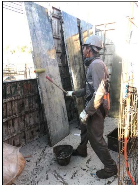
Figura 33 - Aplicação de desmoldante em forma metálica
