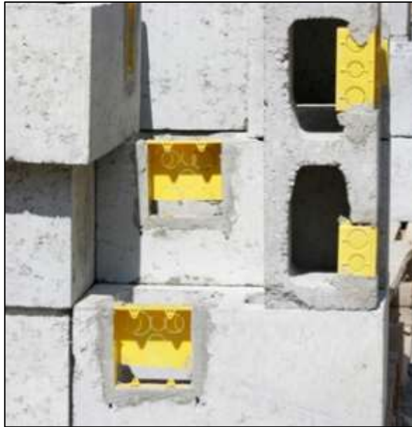
Figura 18 - Caixinhas chumbadas nos blocos de concreto
