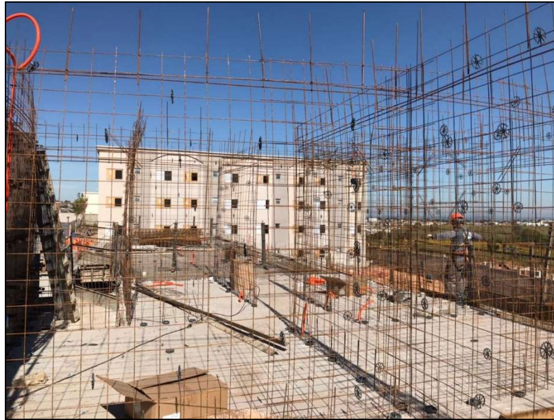
Figura 29 - Montagem das armações com tela soldadas já com os espaçadores
