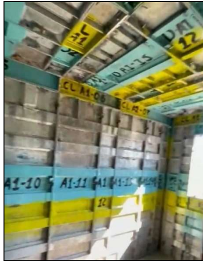
Figura 32 - Numeração de forma para parede de concreto
