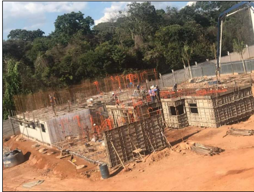
Figura 31 - Montagem dos painéis que compõem a fôrma
