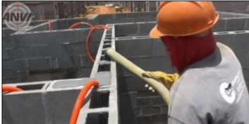
Figura 11 – Lançamento de graute
