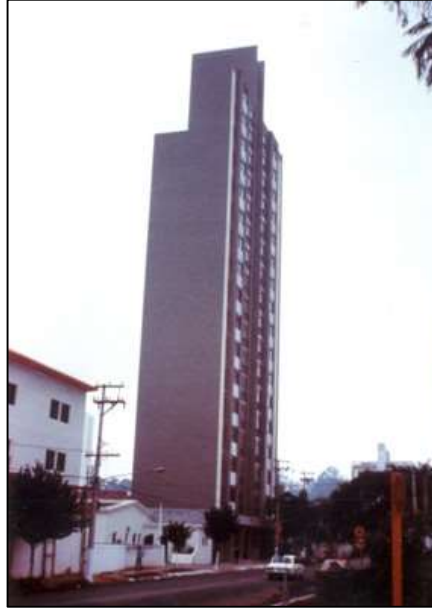
Figura 5 – Edifício Muriti, em São José dos campos – SP, Brasil
