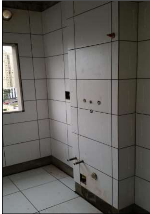
Figura 20 - Shaft hidráulico em sua fase final.
