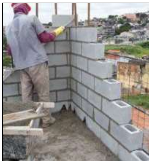
Figura 17 - Assentamento dos blocos pelas extremidades
