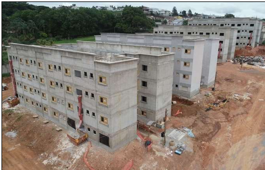
Figura 22 - Prédios construídos pelo método construtivo parede de concreto
