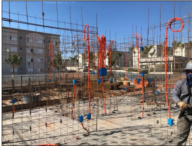
Figura 30 - Colocação de tubulações elétricas e hidráulicas
