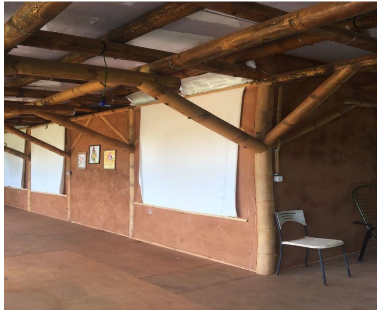
Figura 24 – Parede finalizada com o adobe
