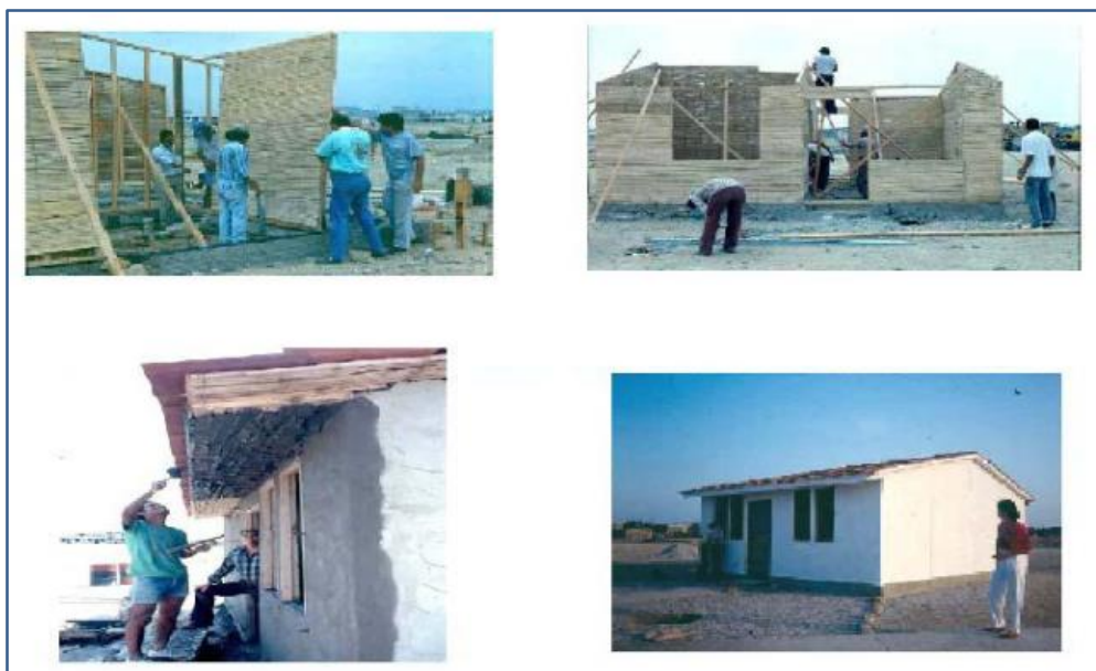
Figura 7 - Vedação feita de bambu: Sequência de execução.
