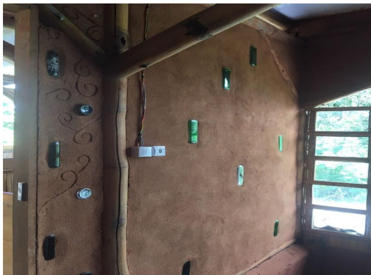
Figura 15 – Parede de adobe com garrafas de vidro encravadas
