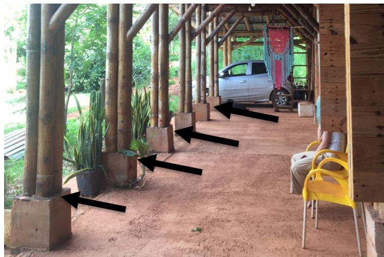
Figura 16 – Blocos de concreto para receber os pilares
