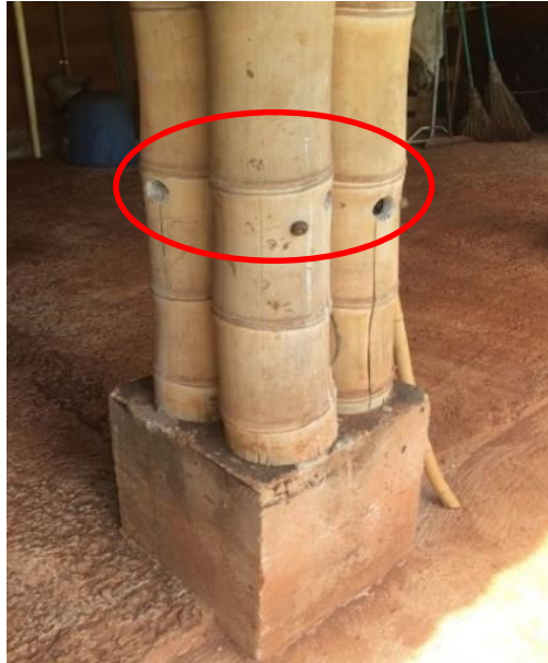
Figura 17 – Furos para introdução da argamassa no interior do colmo
