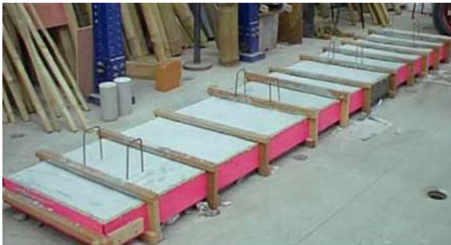
Figura 12 - Forma permanente preenchida com concreto.
