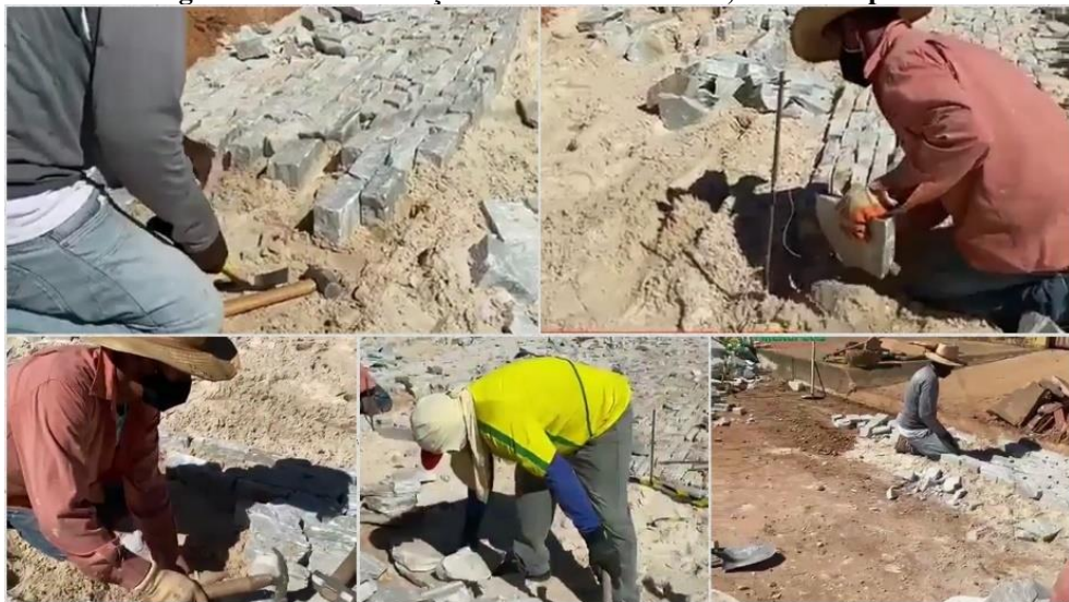
Figura 28 - Pavimentação no setor Meia Ponte, em Pirenópolis
