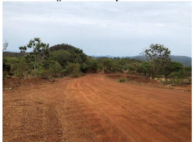
Figura 43 – Alargamento da estrada no seguimento Pirenópolis e PEP
