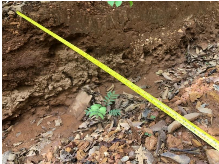
Figura 39 – Largura da vala na estrada-parque dos Pireneus, com 1,40 metros
