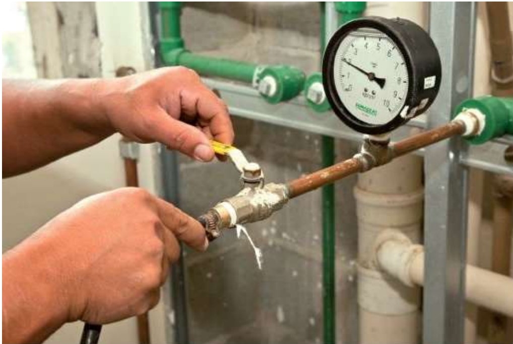
Figura 9: Teste de estanqueidade do sistema predial
