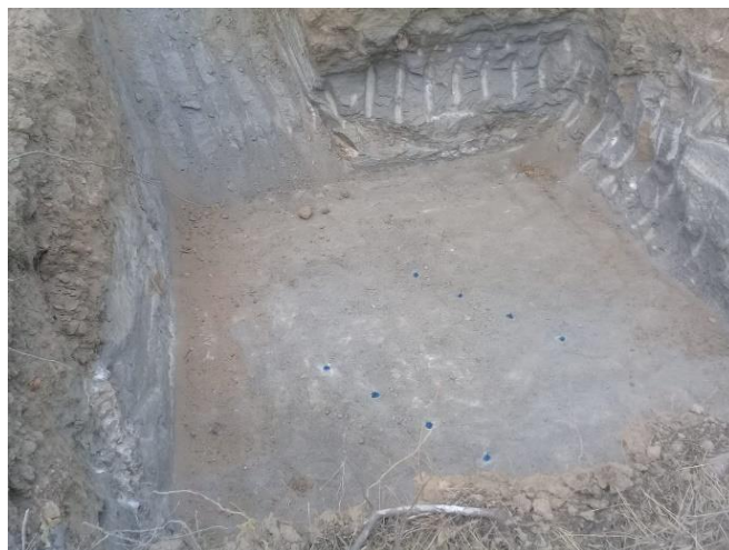
Figura 2: Poço de Inspeção
