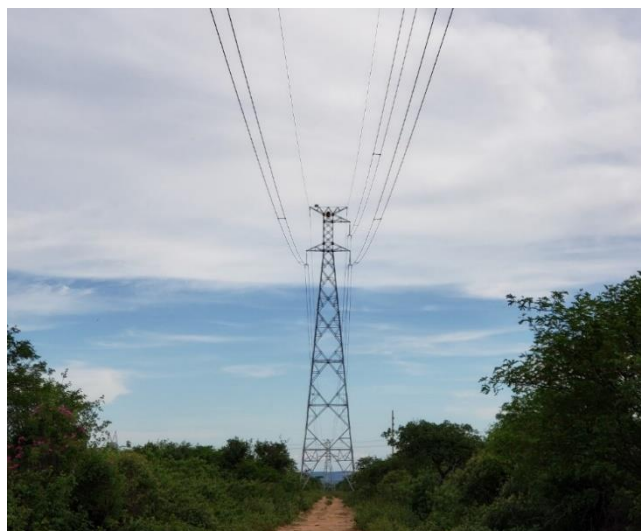
Figura 7: Torre de Suspensão
