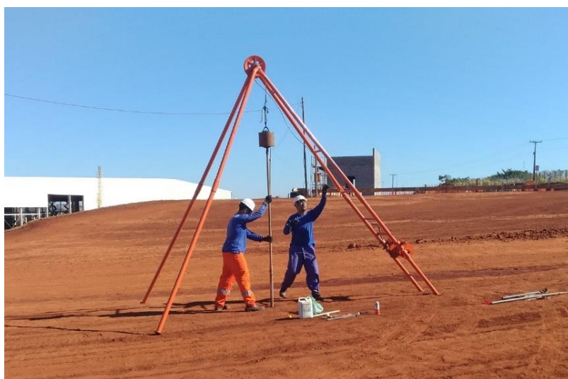
Figura 4: Sondagem à Percussão
