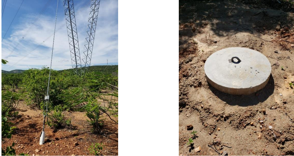
Figura 12: Estai conectado por vari-grip (a) e Grampo de ligação entre o estai e a fundação (b)
