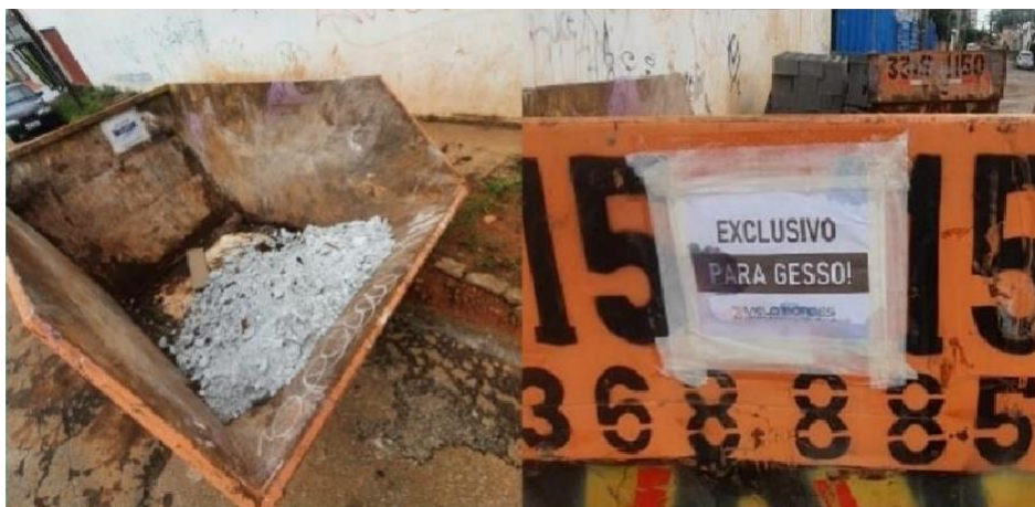
Figura 14 – Caçamba para depósito exclusivo de gesso
