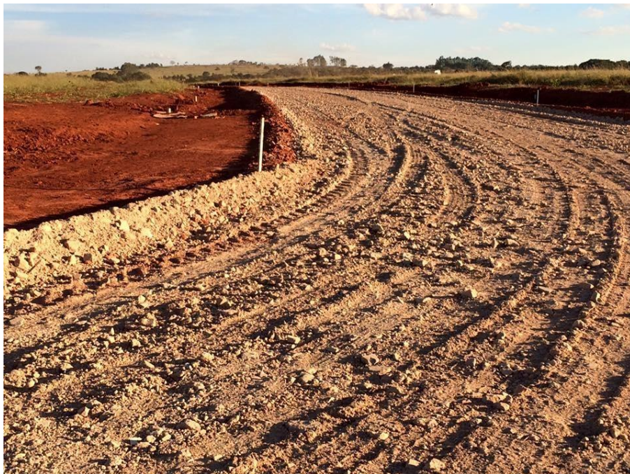
Figura 9 - Base feita de concreto reciclado
