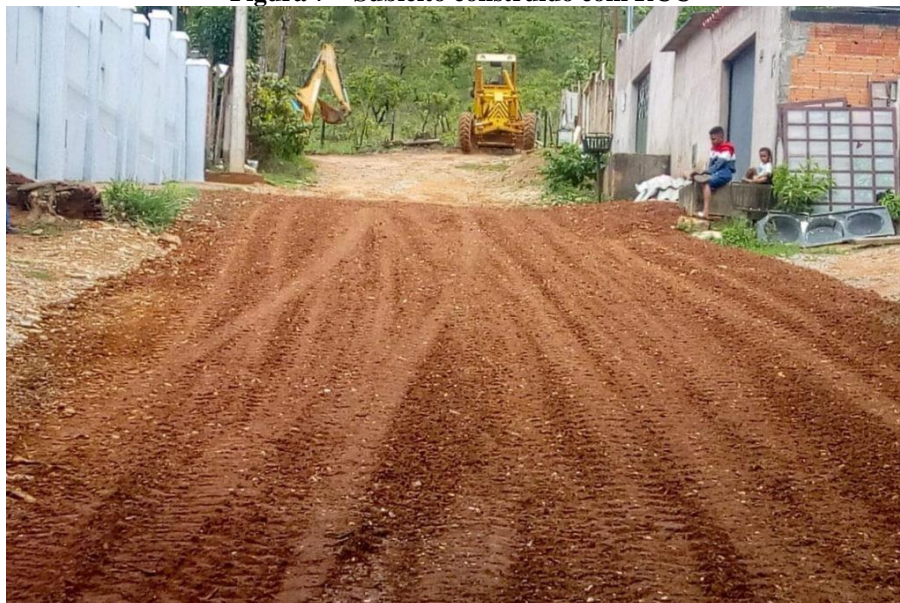
Figura 7 – Subleito construído com RCC
