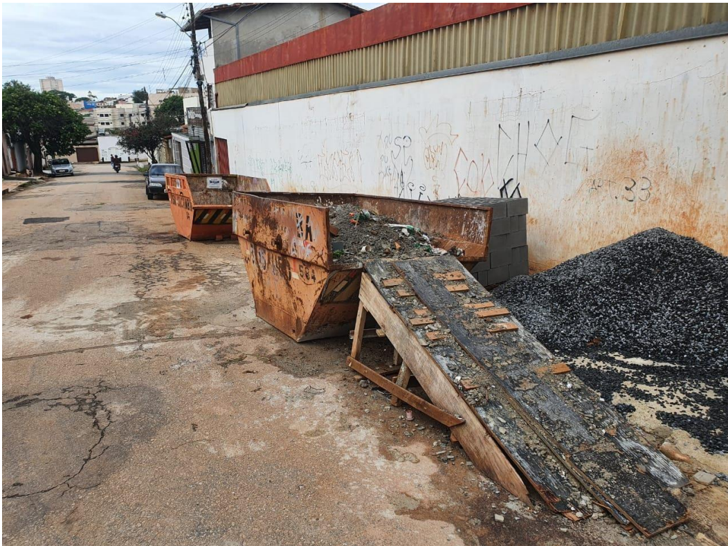
Figura 21 - Caçambas de resíduos separadas conforme o tipo
