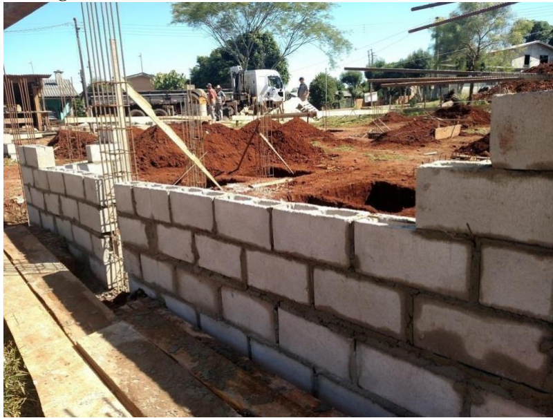
Figura 6 – Parede sendo construída com blocos feitos de RCC
