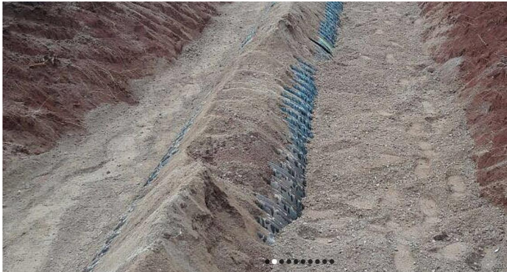
Figura 15 – RCD utilizado em interceptor de rede de esgoto
