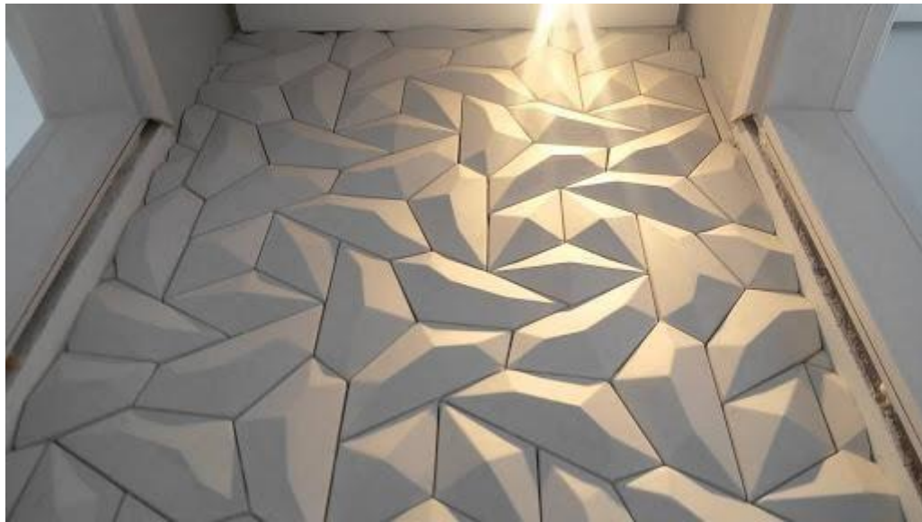
Figura 29 - Parede com aplicação de placas de Gesso 3D
