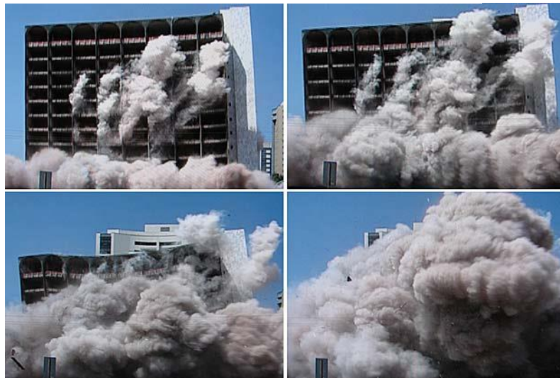
Figura 14 - Demolição por explosões
