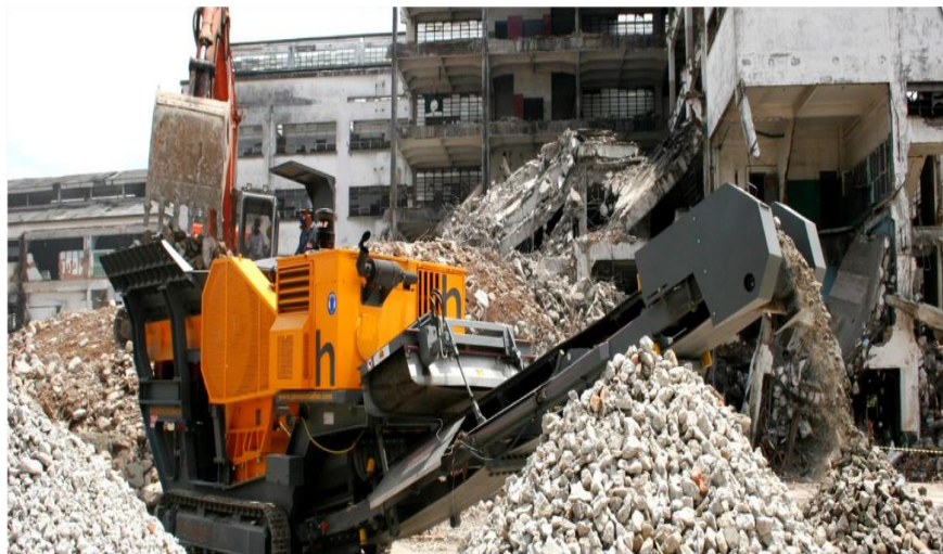
Figura 13 - Demolição e trituração no local
