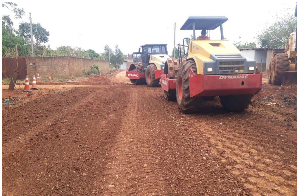
Figura 36 – Compactação do solo
