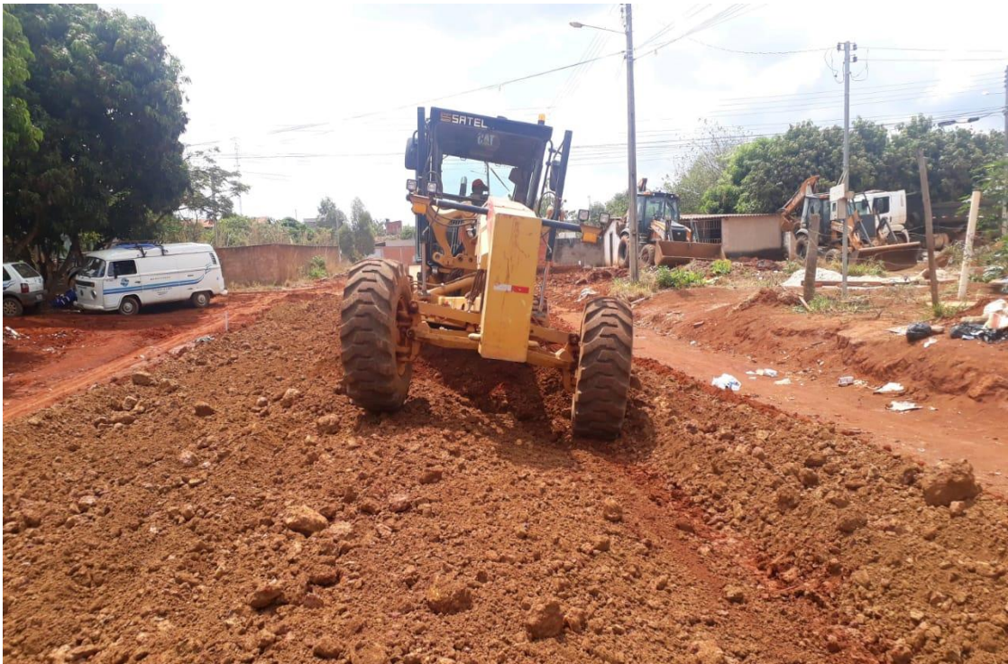
Figura 34 – Execução do aterro
