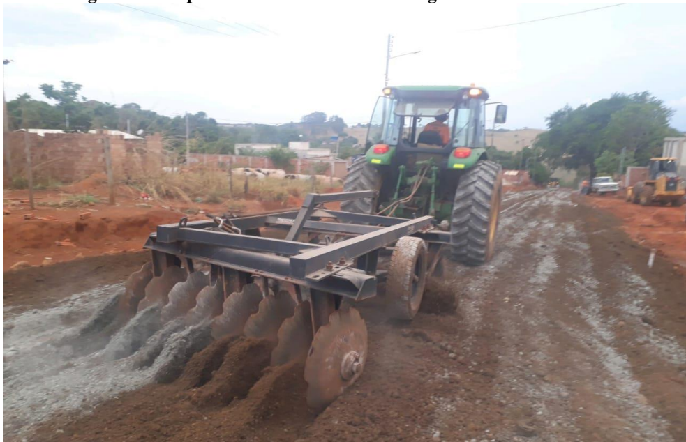
Figura 38 – Espalhamento da mistura com a grade de disco
