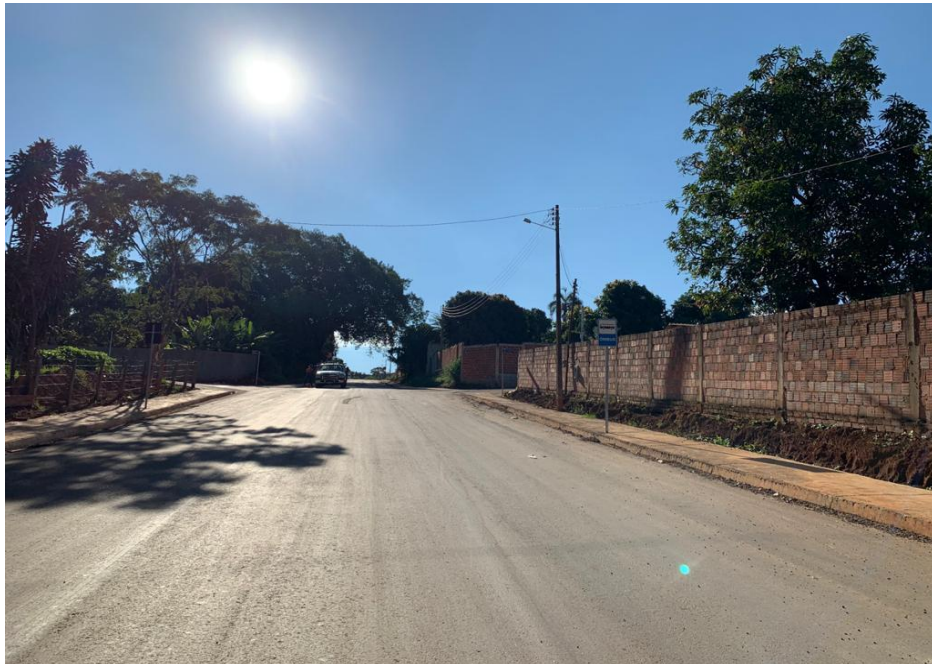
Figura 23 – Finalização da obra
