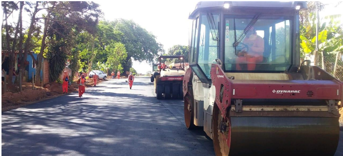
Figura 39 – Compactação da capa asfáltica
