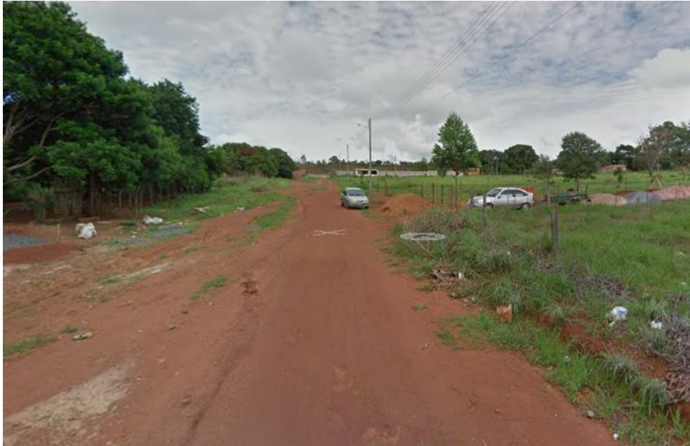
Figura 22 – Início da obra
