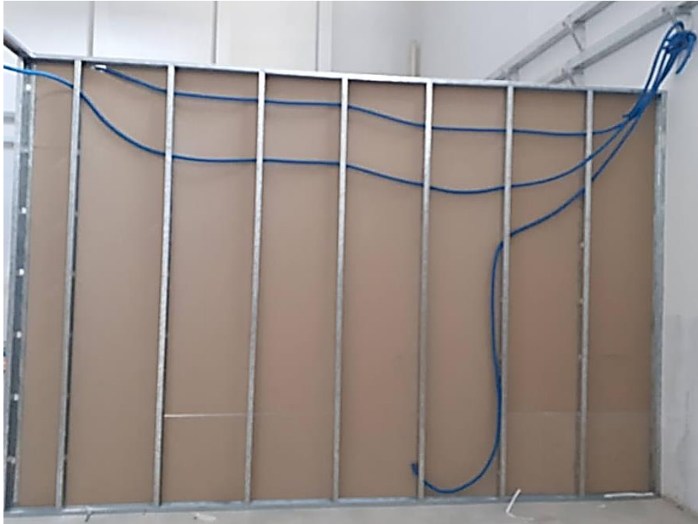
Figura 20 – Instalações elétricas no drywall
