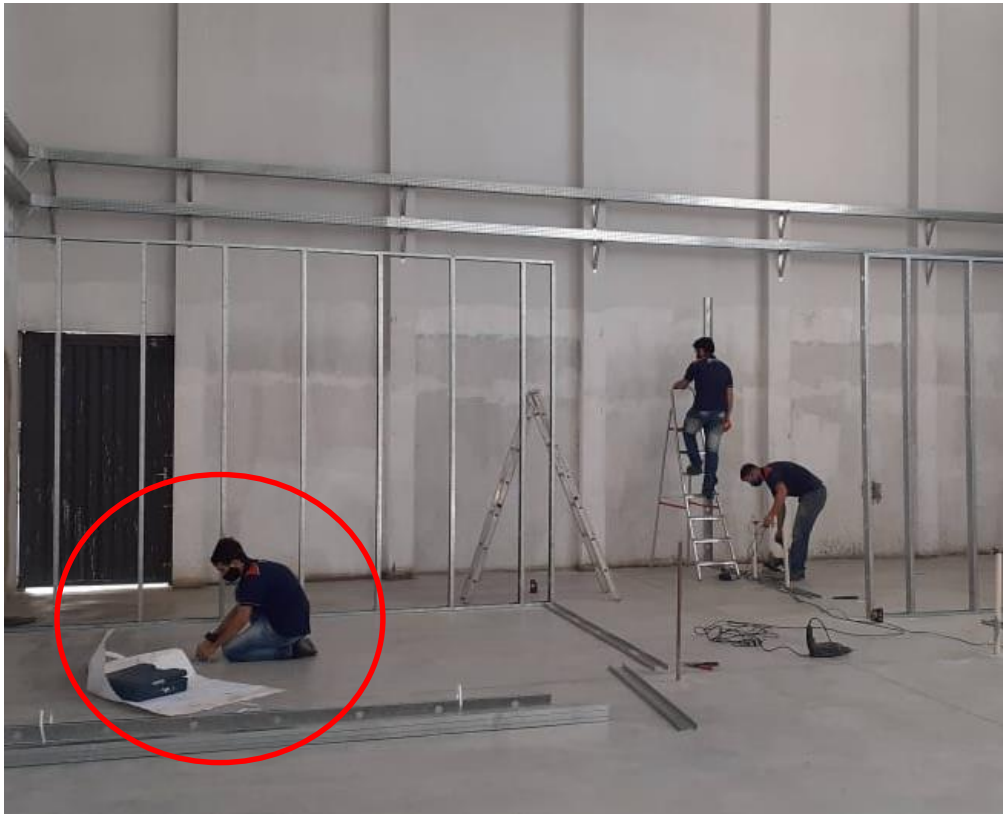
Figura 13 – Marcação das paredes.
