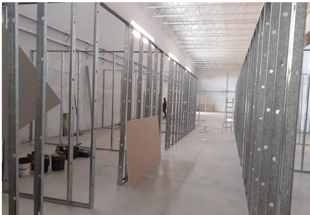
Figura 18 – Guias superiores e inferiores e montantes fixados.
