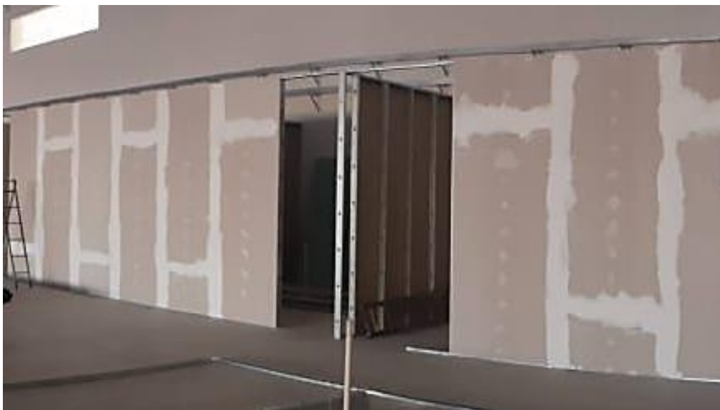
Figura 21 – Acabamento da estrutura de drywall
