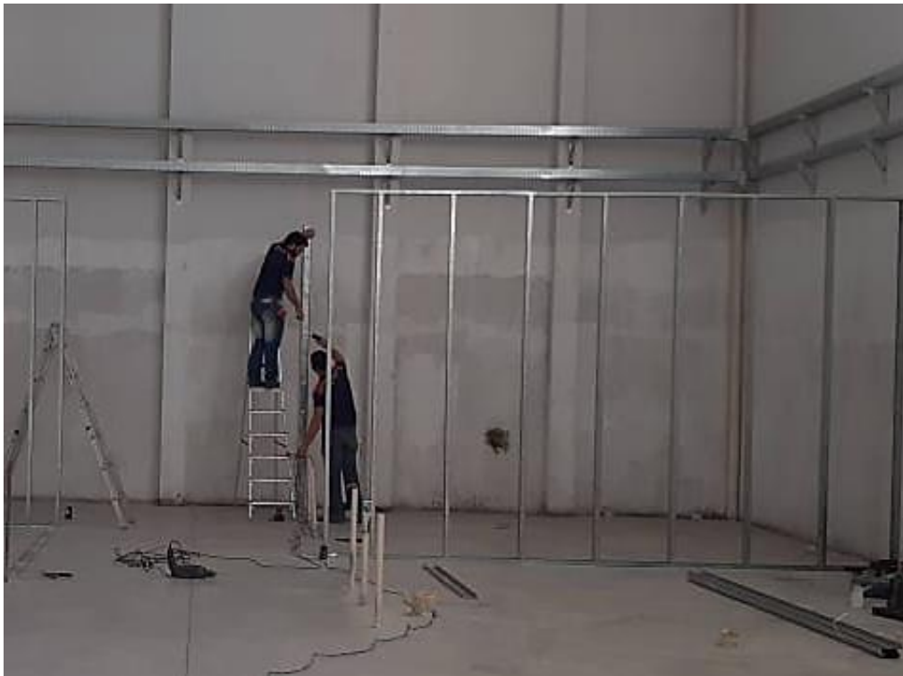
Figura 16 - Medição da altura do montane para corte
