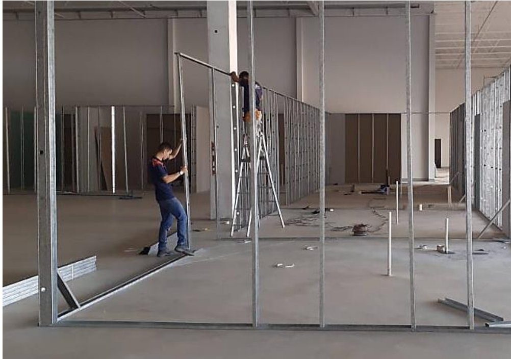
Figura 17 - Fixação dos montantes nas guias.
