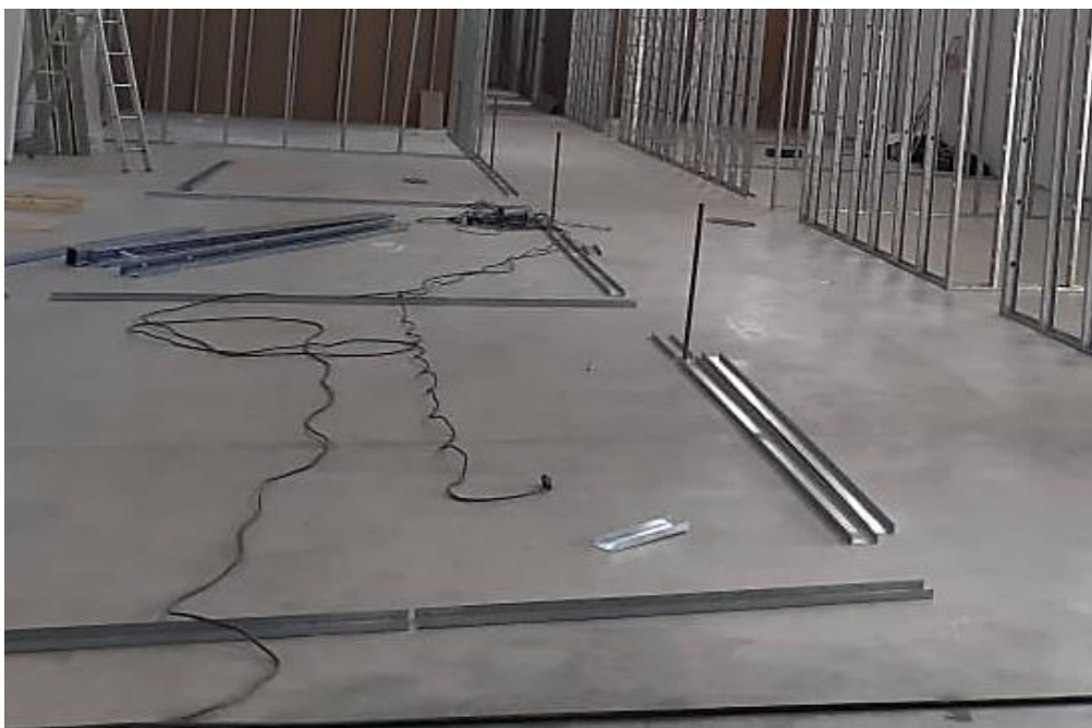
Figura 15 – Fixação das guias inferiores.
