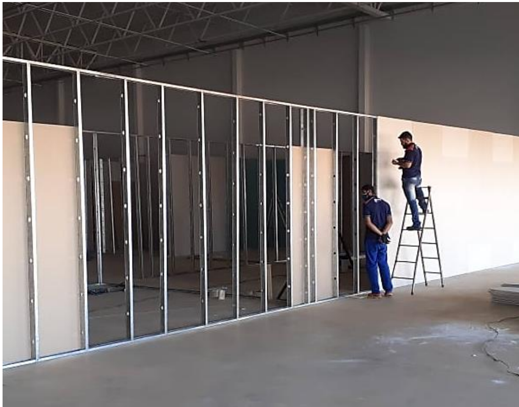
Figura 19 – Posicionamento e montagem dos painéis na estrutura.
