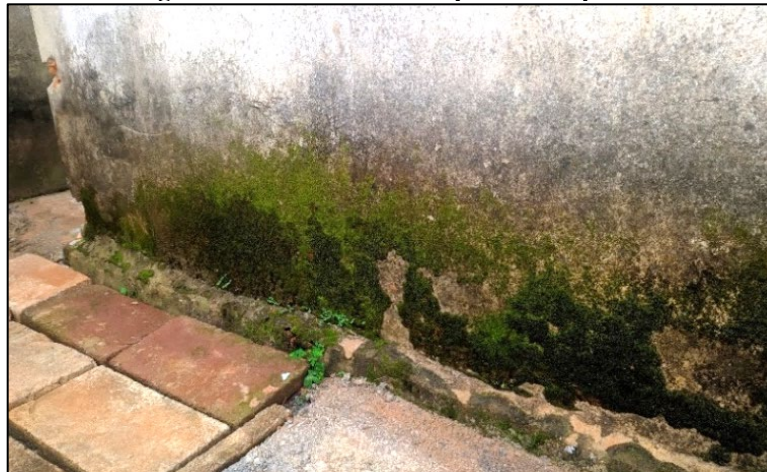
Figura 47 - Base externa da parede do quarto
