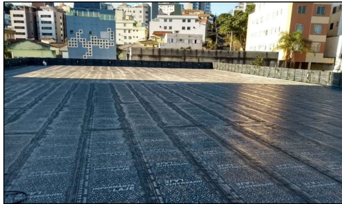
Figura 37 - Laje de cobertura impermeabilizada com manta asfáltica
