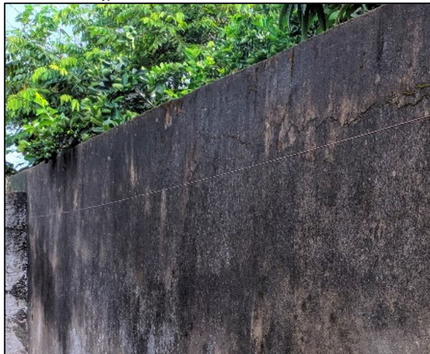
Figura 51 - Muro do fundo do lote
