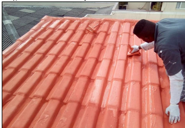
Figura 39 - Pintura impermeabilizante em telhados
