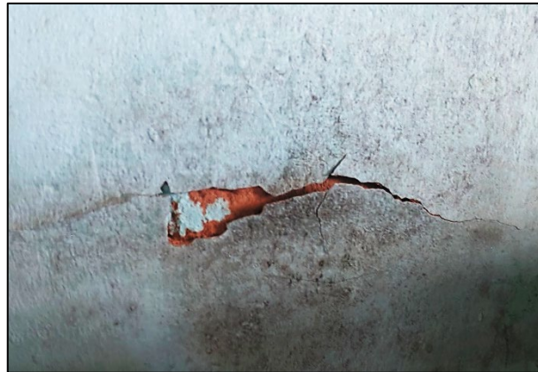
Figura 54 - Parede de divisa da sala e a nova edificação
