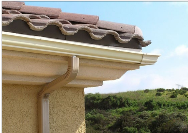
Figura 40 - Coletor de águas pluviais
