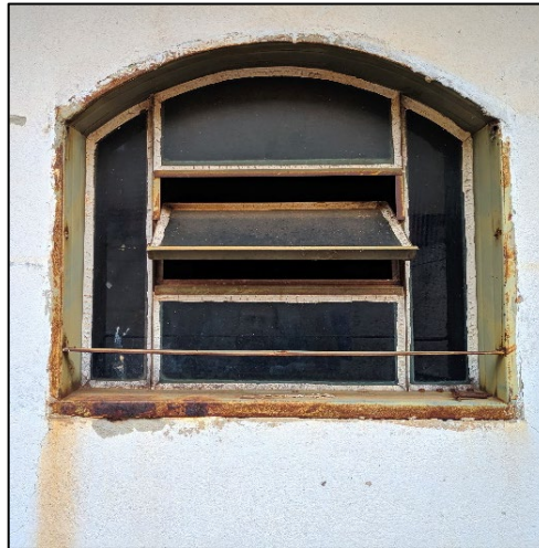
Figura 52 - Janela do banheiro
