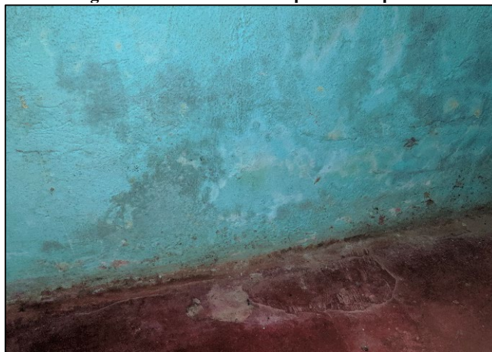
Figura 48 - Base interna da parede do quarto
