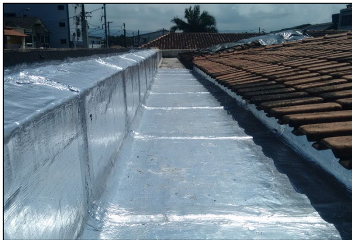
Figura 41 - Calha impermeabilizada com manta asfáltica aluminizada
