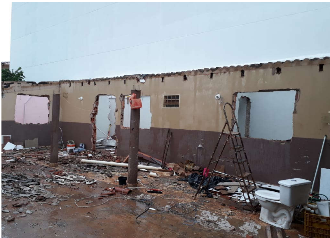
Figura 25 – Condições iniciais do terreno: edificação existente
