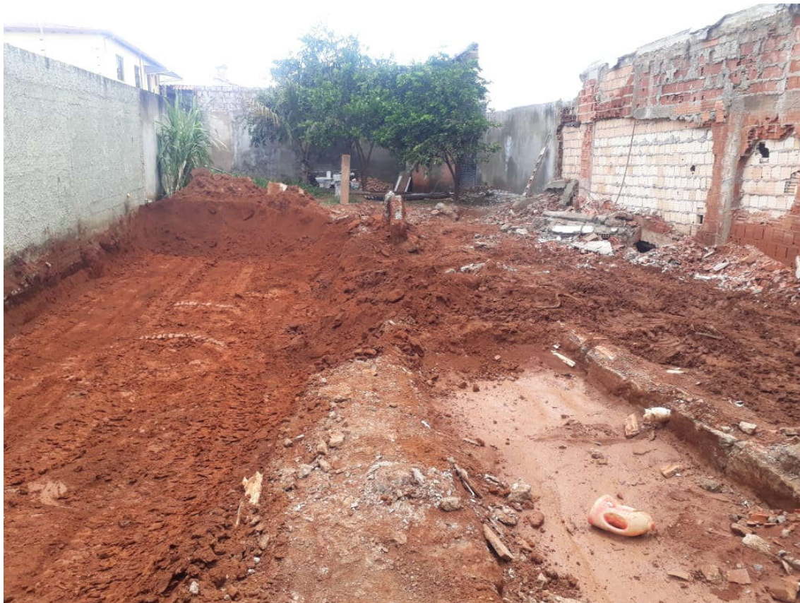
Figura 26 – Condições iniciais do terreno: vegetação
